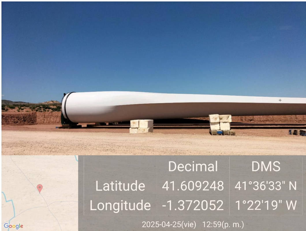
Ilustración 6. Palas acopiadas correctamente sin afcción a la vegetación ni al drenaje natural
