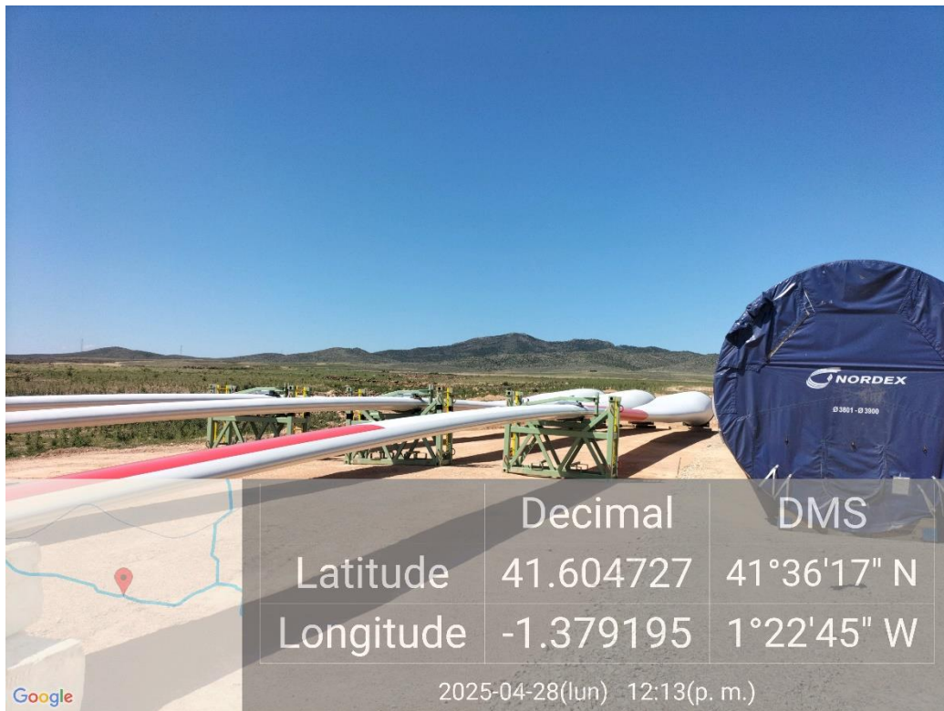
Ilustración 9. Los componentes de los aerogeneradores se acopiados correctamente sin afectar a la vegetación ni al drenaje natural.
