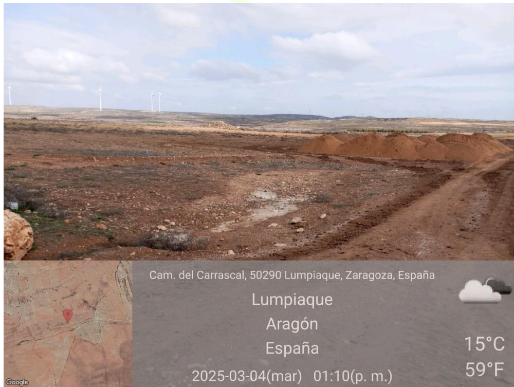
Ilustración 3. Residuos derivados de la limpieza de hormigón en la plataforma 08.
