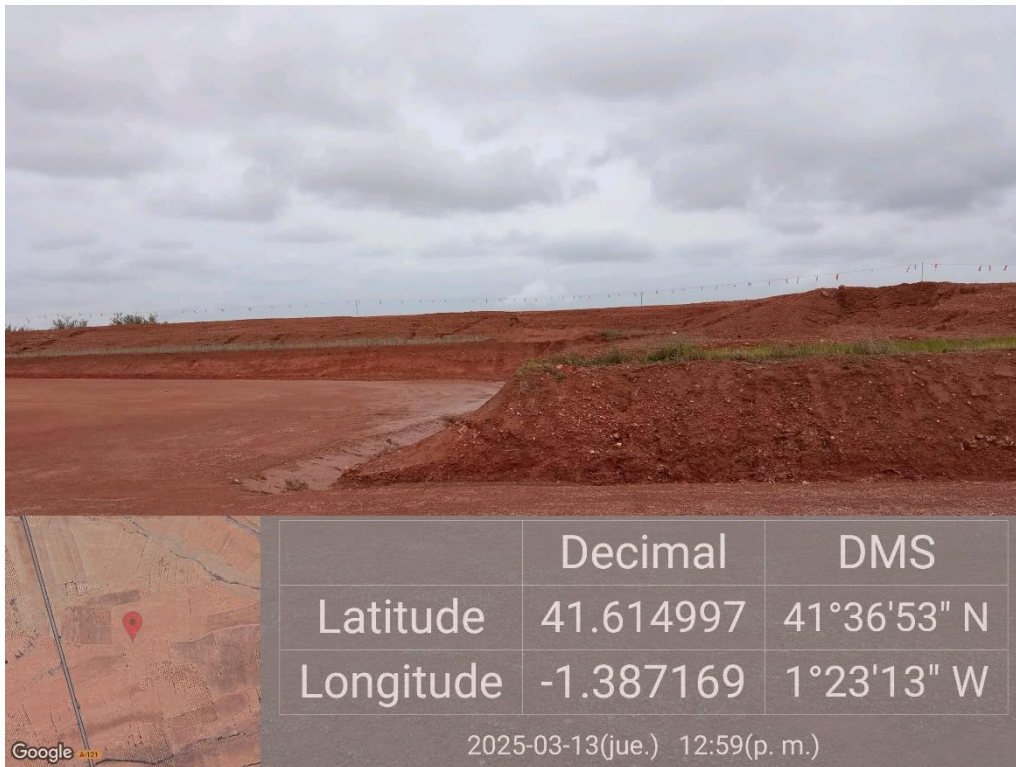
Ilustración 4. Tierra vegetal separada de material inerte y acopiada correctamente
