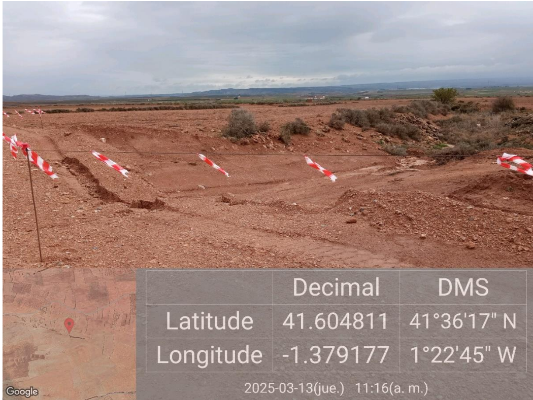
Ilustración 7. Vial de acceso construido atravesando el desagüe de un pequeño barranco natural..
