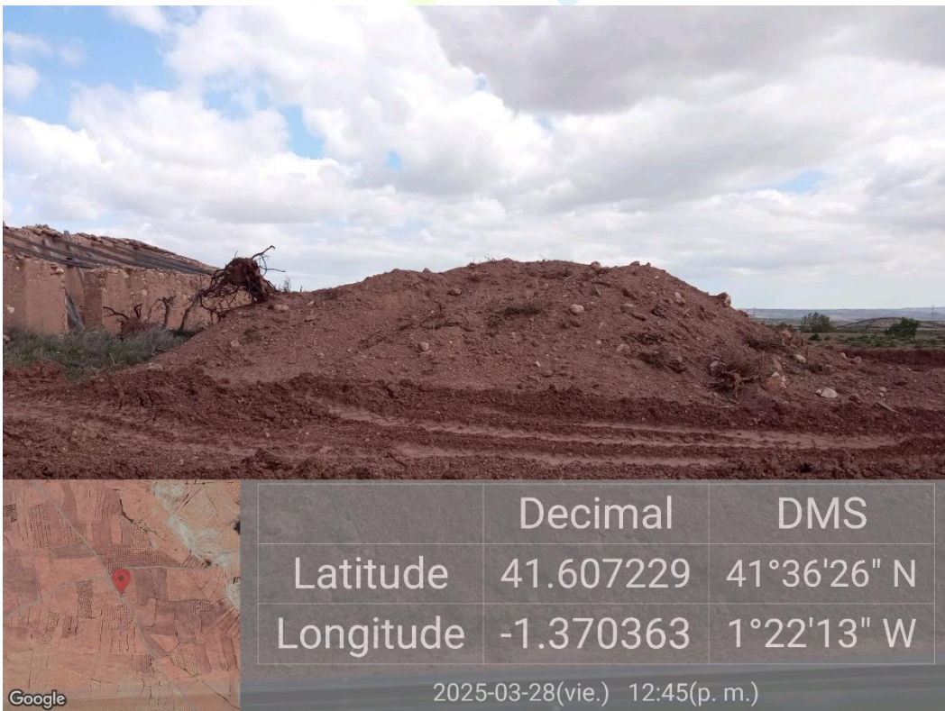
Ilustración 10. Tierra vegetal acopiada correctamente, pero con grandes restos vegetales
