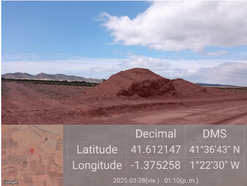
Ilustración 9. Sobrantes de excavación de la plataforma 05.
