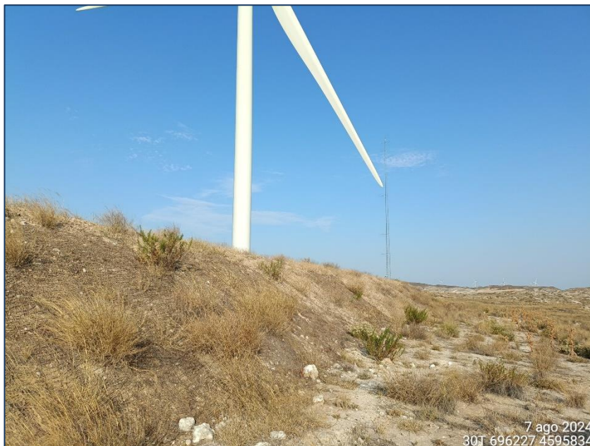
Fotografía 2. Revegetación en talud.
