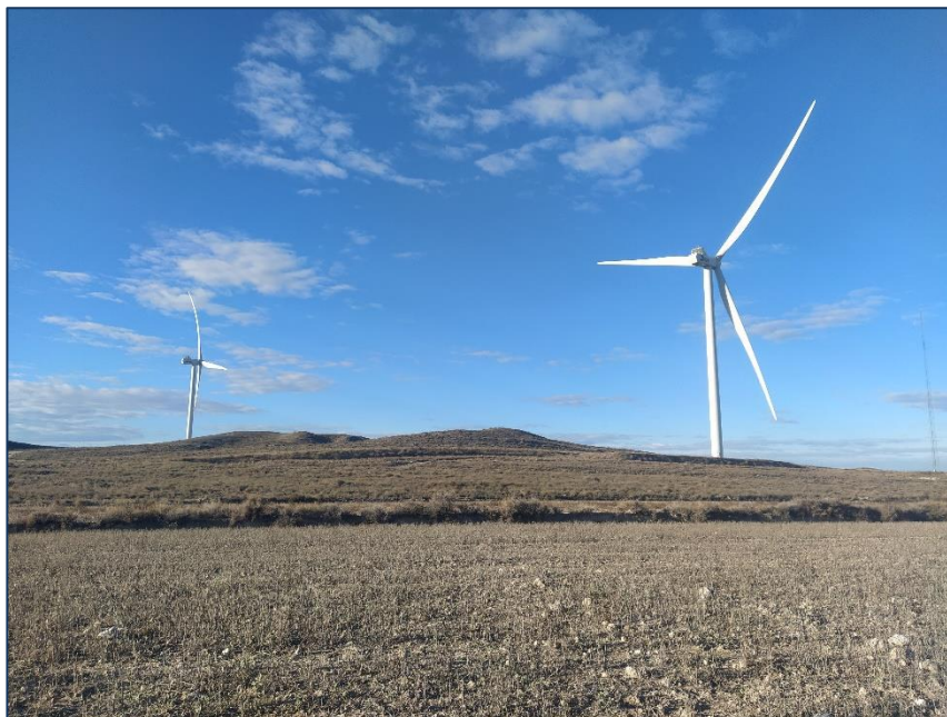
Fotografía 7. Parque eólico visto desde la subestación.
