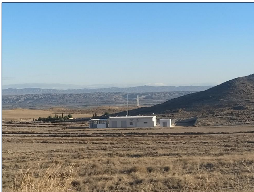
Fotografía 8. Entorno de la subestación.
