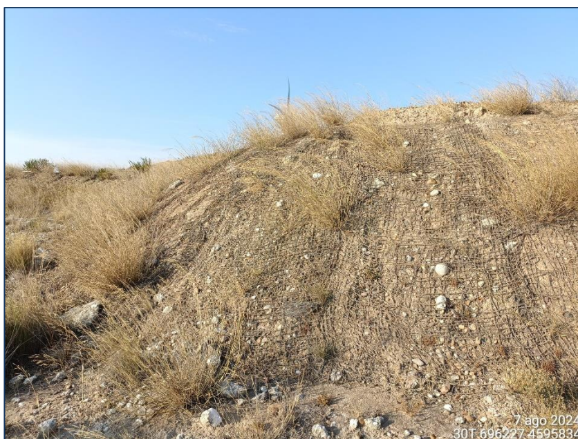
Fotografía 3. Malla de fibra vegetal.
