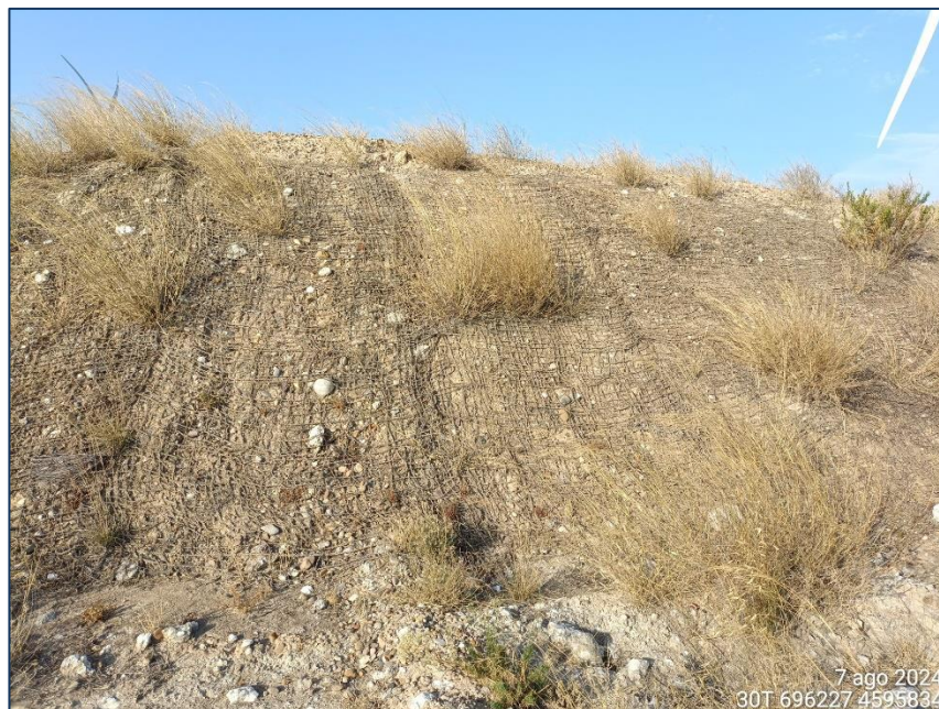
Fotografía1. Revegetación en talud.
