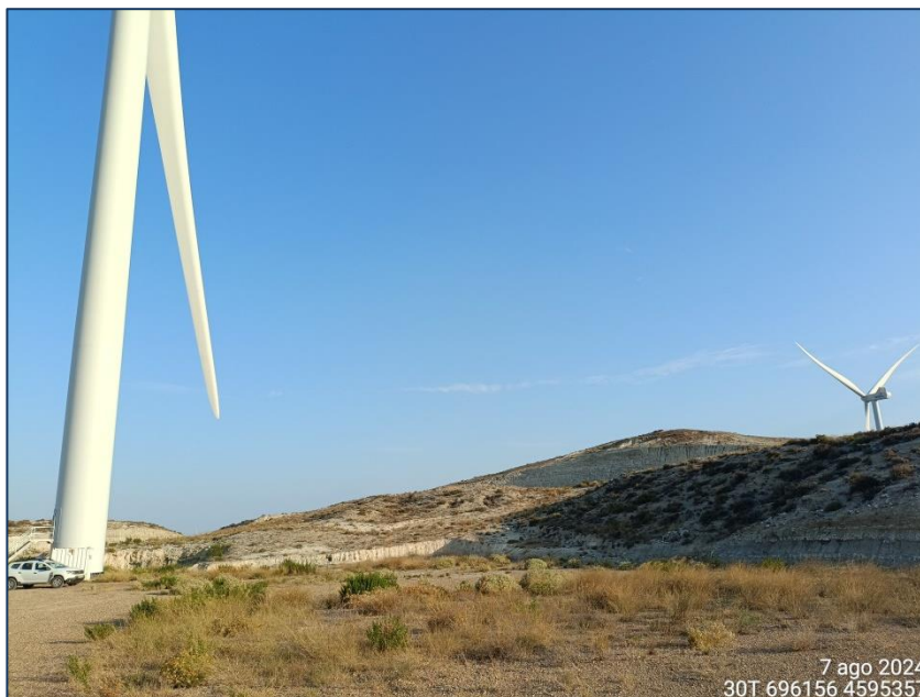
Fotografía 4. Zona junto a plataforma.
