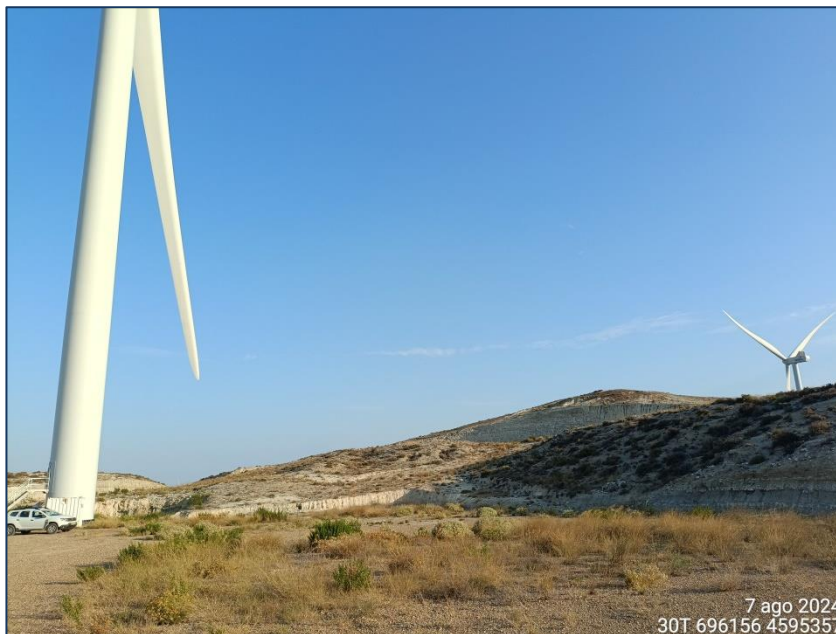
Fotografía 4. Zona junto a plataforma 1.
