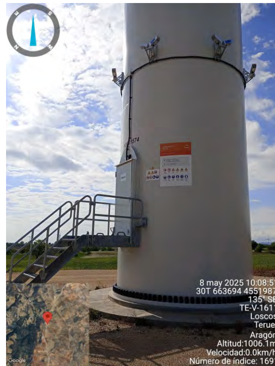
Fotografías 11 y 12: Señalización de las torres de los aerogeneradores
