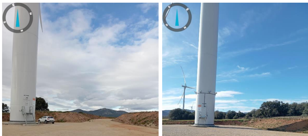
Fotografías 24 y 25: Taludes
