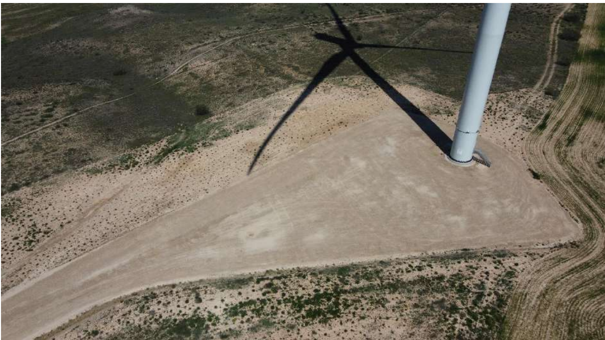
Foto nº2.: Plataforma del Aerogenerador REA-02.
