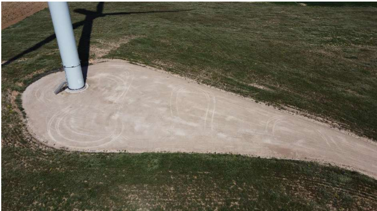
Foto nº4.: Plataforma del Aerogenerador REA-04.
