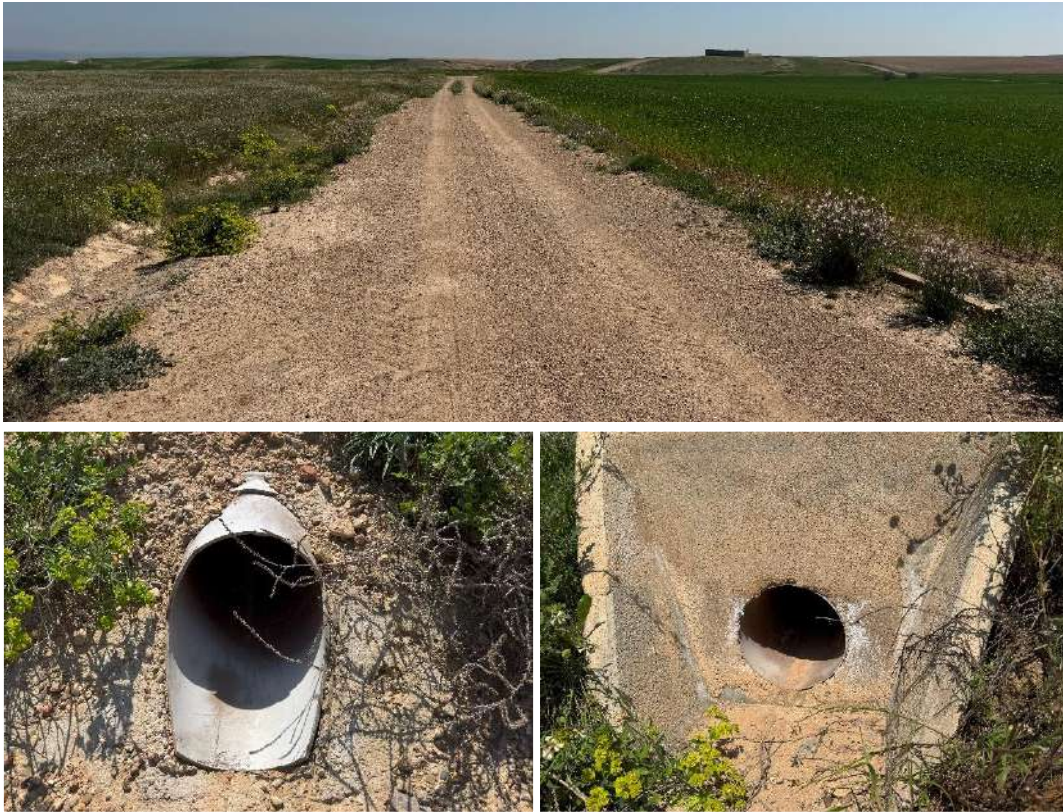
Foto nº10.: Drenaje de vial de acceso a REA-04.
