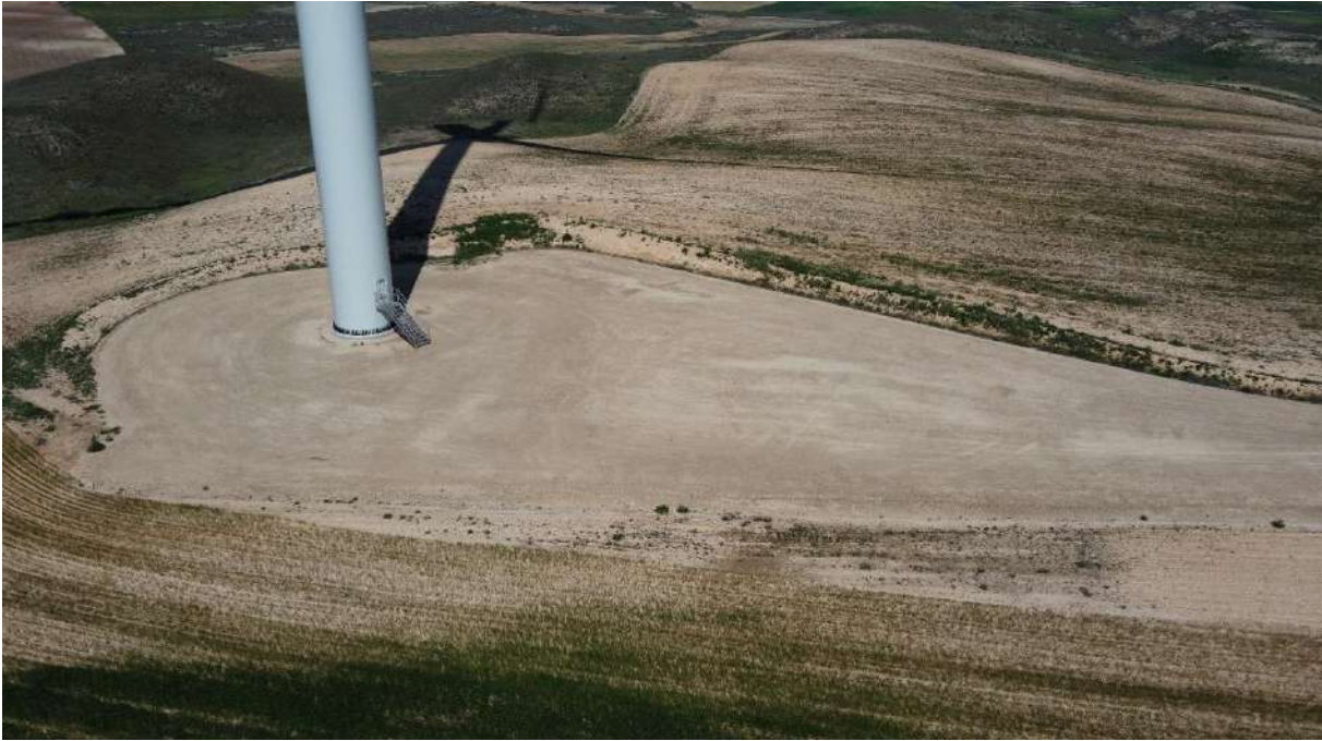
Foto nº1.: Plataforma del Aerogenerador REA-01.
