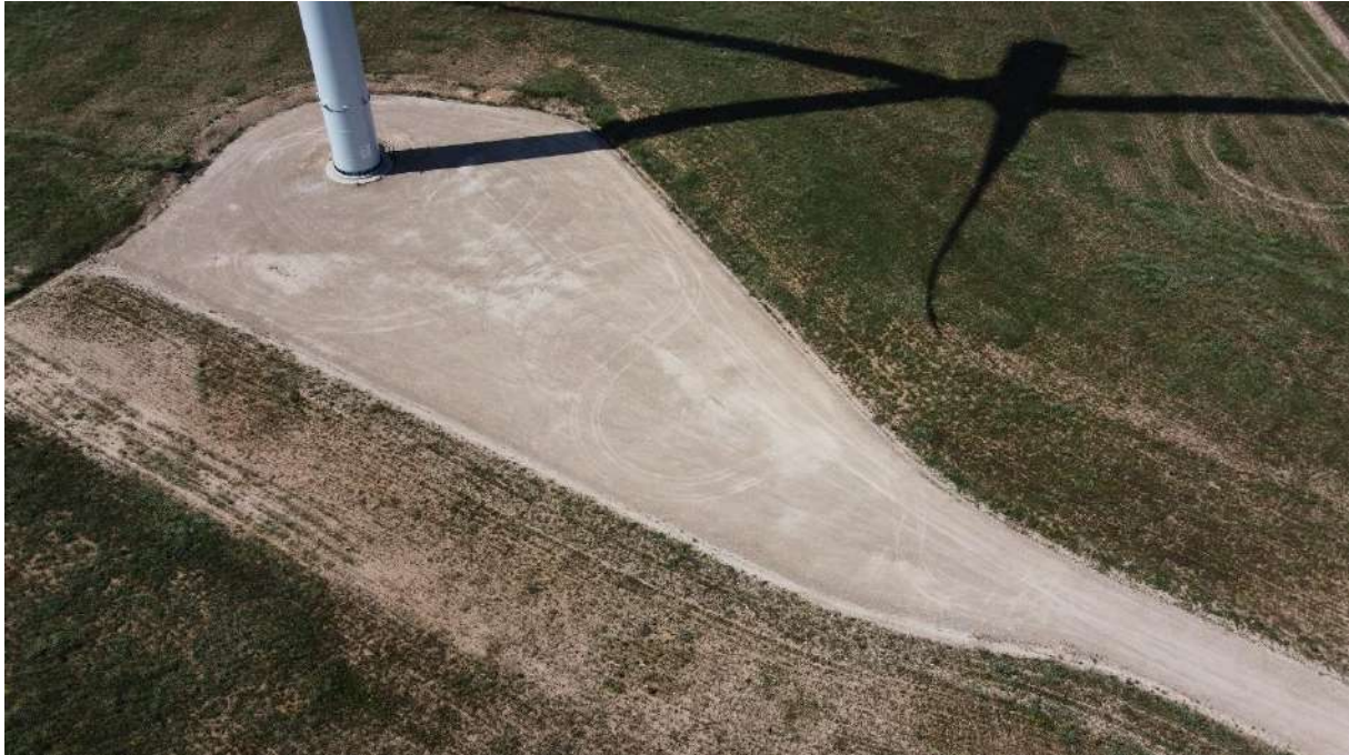
Foto nº5.: Plataforma del Aerogenerador REA-05.
