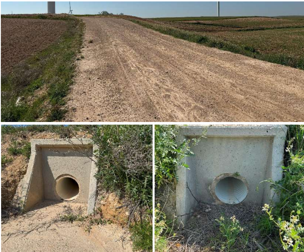
Foto nº9.: Drenaje de vial de acceso a REA-03.
