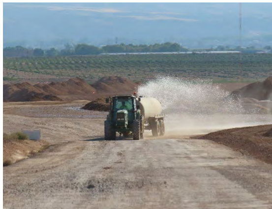
Cuba regando las superficies transitadas de las obras.
