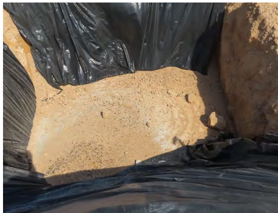
Pozo de lavado de hormigoneras.
