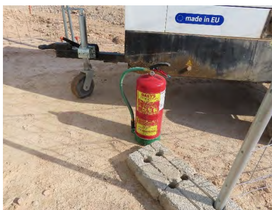
Extintor disponible junto a grupo electrógeno de las casetas de obra.
