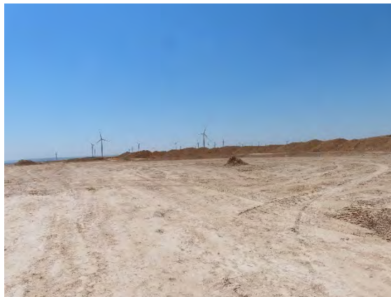
Plataforma del aerogenerador REIIA-03 con las obras paradas.
