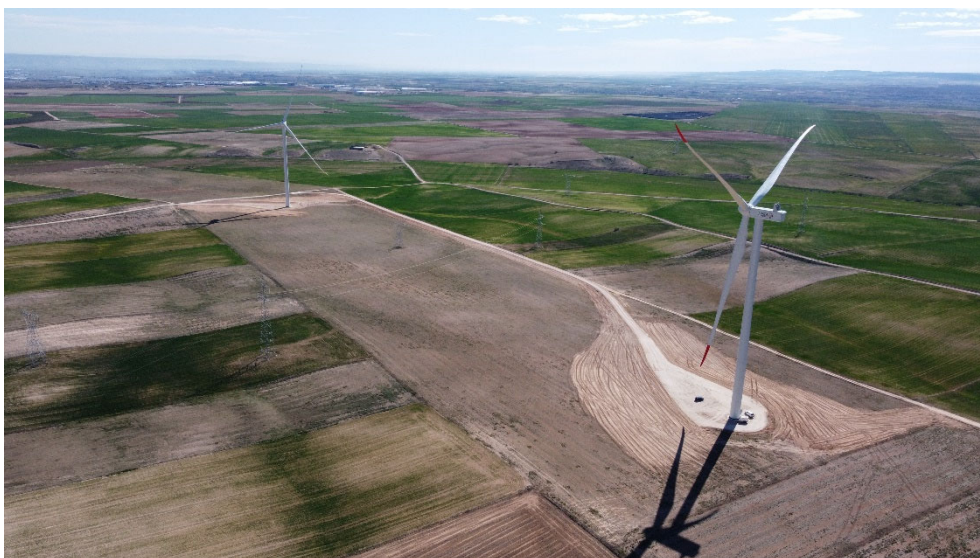
Vista aérea de los aerogeneradores REA-04 y REA-05.
