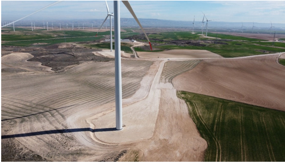
Vista aérea de los aerogeneradores REA-01 y REA-02.
