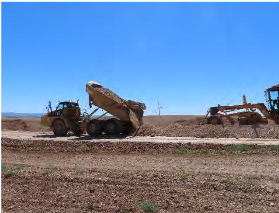
Compensación de tierras. Relleno en viales con tierras de excavación de las cimentaciones.
