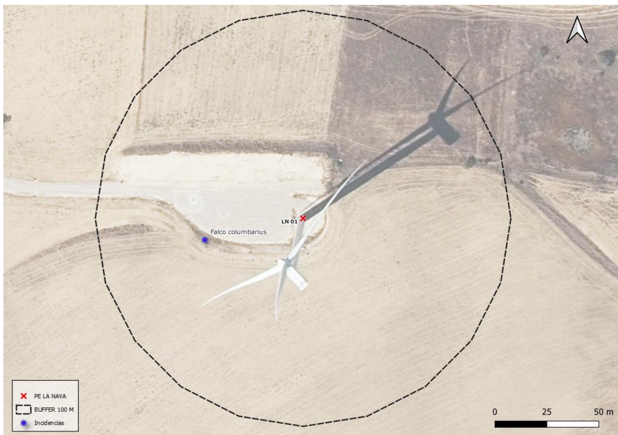
Imagen 3. Incidencias detectadas en el aerogenerador LN 01 .
