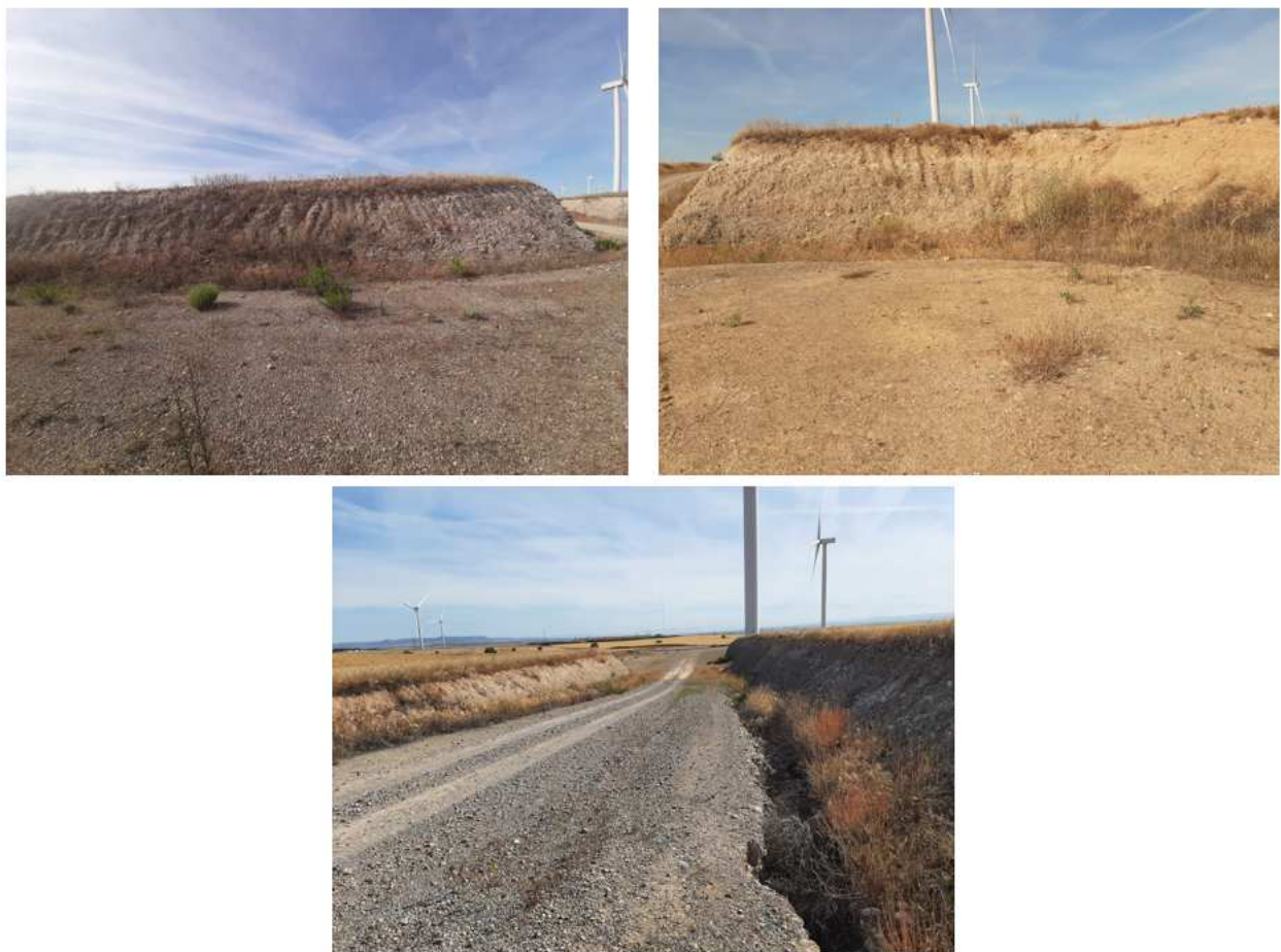
Imagen 30. Control de procesos erosivos de taludes y viales en el aerogenerador LN 02.
