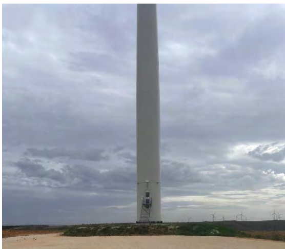
Fotografía 8. Estado de las revegetaciones en LCI-03
