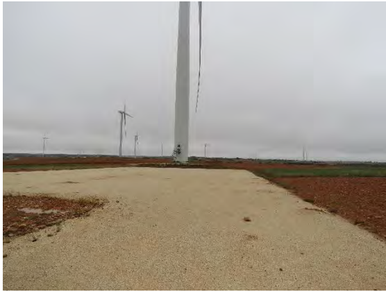
Fotografía 6. Viales de acceso a LCI-02
