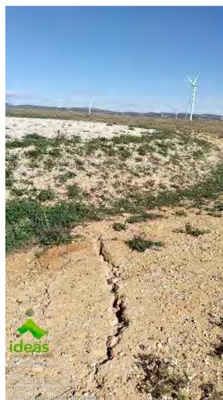
Fotografía 16. Grieta en plataforma de aerogenerador CO2-05
