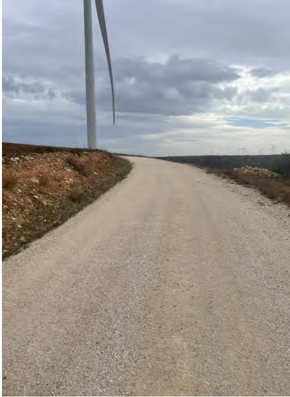
Fotografía 5. Viales de acceso a LCII-15
