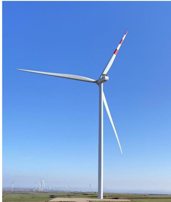
Figura 13: Foto del aerogenerador ELT-03 con la medida preventiva de pintado de pala.
