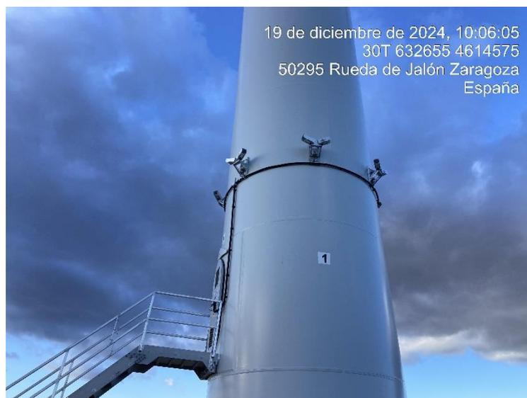
Figura 11: Sistema 3D Observer instalado en el presente cuatrimestre sobre la torre del aerogenerador ELT-01.
