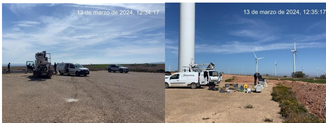
Figura 11: Colocación de la torre para el sistema “3D Observer” en la plataforma del aerogenerador ELT-02.
