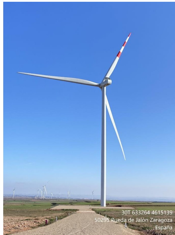
Figura 14: Foto del aerogenerador ELT-03 con la medida preventiva de pintado de pala.
