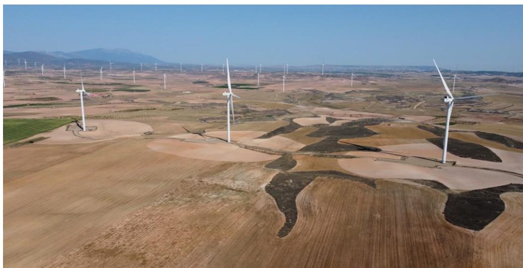
Figura 12: Fotografía tras el labrado y compactado del área de 136 metros en torno a los aerogeneradores 1 al 9 de El Llano.
