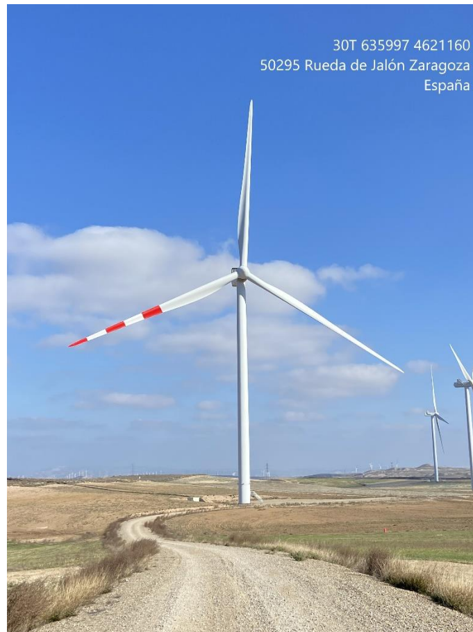
Figura 15:Foto del aerogenerador ELL-07 con la medida preventiva de pintado de palas.
