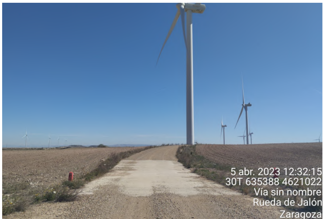
Figura 37: Badén de hormigón inundable en vial entre ELL-5 y ELL-4 en correcto estado.
