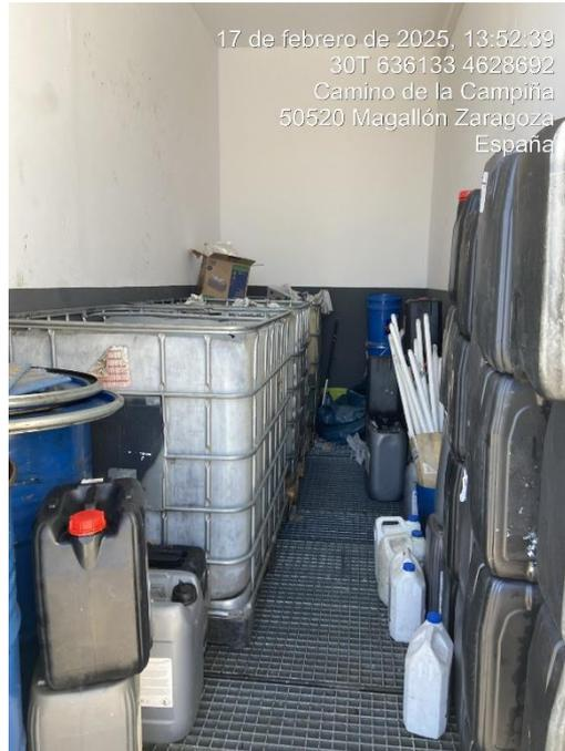
Figura 15: Interior del almacén de residuos peligrosos del PE Campo de Magallón.
