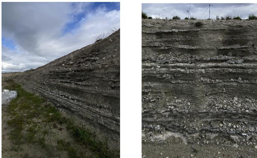
Figura 14: Talud del aerogenerador CDM-02 con erosiones más acusadas.
