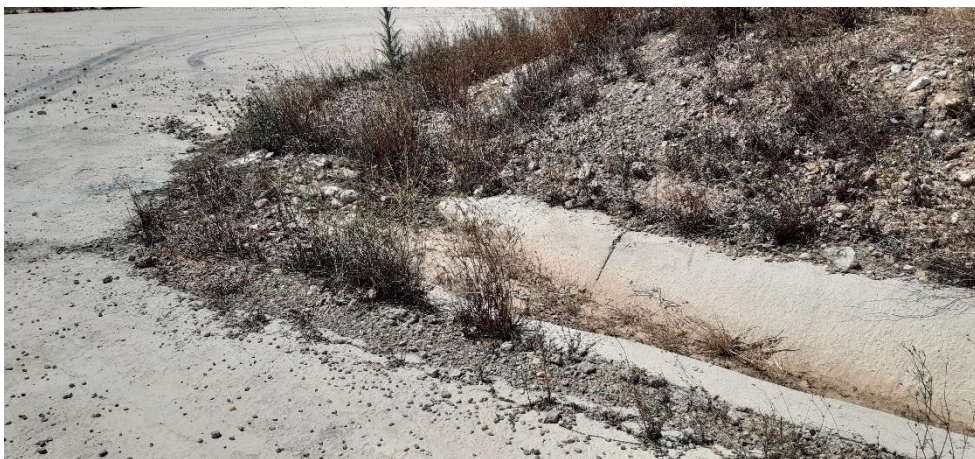
Fig. 1 Cuneta llena de sedimentos en vial de acceso al aero VR2.08
