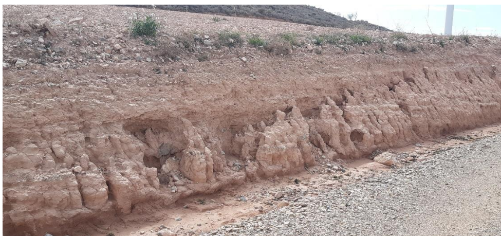
Fig. 1 Erosión hídrica en materiales lutíticos del talud de desmonte del vial de acceso al aero VR2.14.
