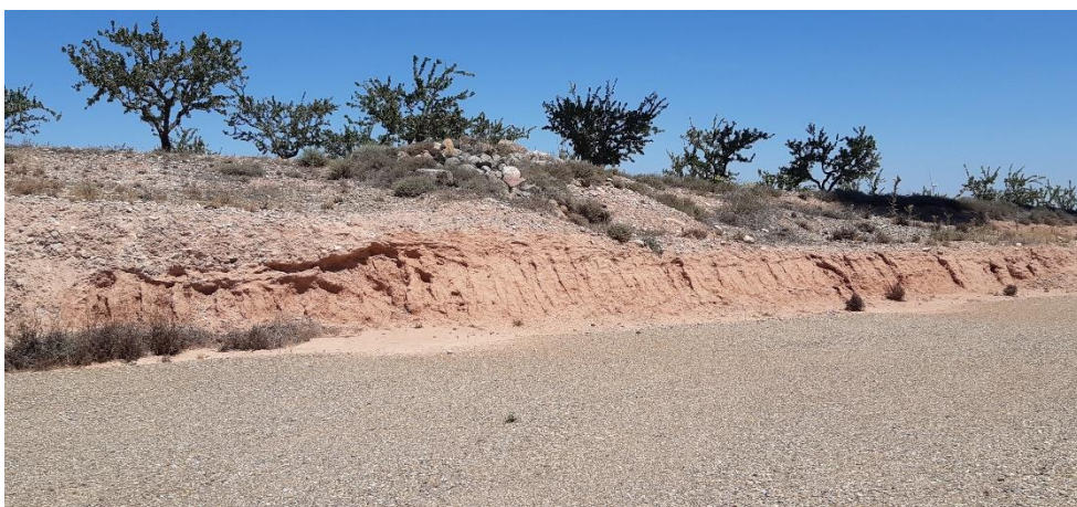
Fig. 2 Erosión hídrica en materiales lutíticos del talud de desmonte de plataforma del aero VR2.15
