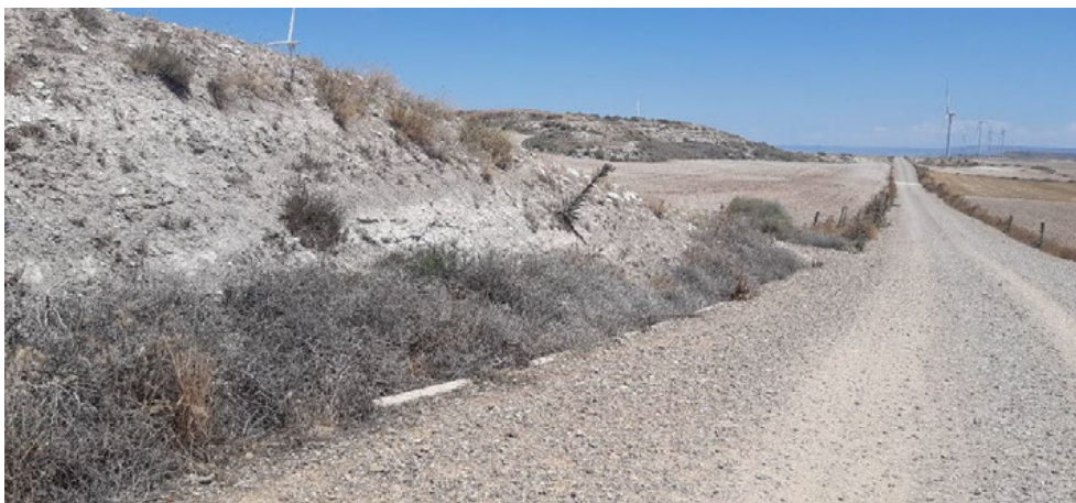
Fig. 2 Cuneta llena de vegetación arbustiva en vial de acceso al aero VR1.07. Afecta a ODT.
