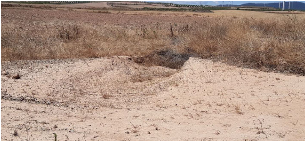
Fig. 2 Erosión hídrica en materiales lutíticos de la plataforma del aero VR1.02.
