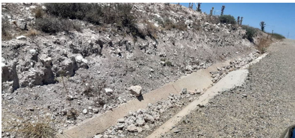
Fig. 2 Cuneta llena de sedimentos en vial de acceso al aero VR1.07.
