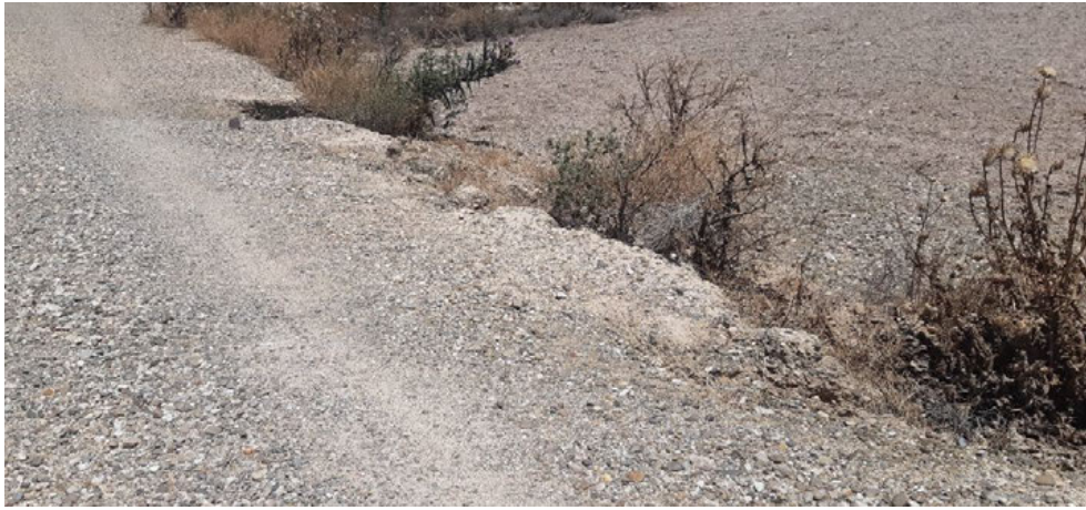
Fig. 1 Erosión hídrica en materiales detríticos del vial de acceso al aero VR1.07. Peligro para circular
