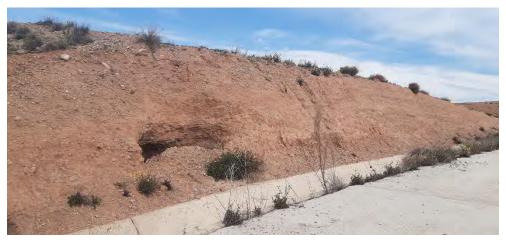
Fig. 4 Erosión hídrica en materiales lutiticos del talud de desmonte del vial de acceso al aero VR1.12.
