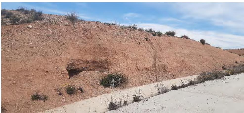
Fig. 4 Erosión hídrica en materiales lutíticos del talud de desmonte del vial de acceso al aero VR1.12.
