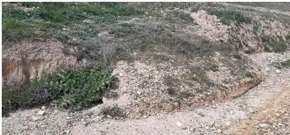
Fig. 2 Tubo de drenaje taponado por vegetación arbustiva y sedimentos en vial de acceso al aero VR1.07
