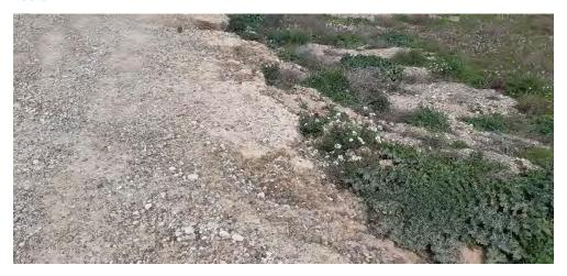
Fig. 1 Erosión hídrica en materiales detríticos del vial de acceso al aero VR1.07. Peligro para circular
