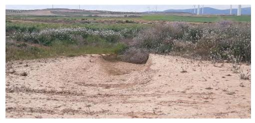
Fig. 2 Erosión hídrica en materiales lutiticos de la plataforma del aero VR1.02.
