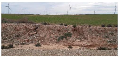
Fig. 3 Erosión hídrica en materiales lutiticos del talud de desmonte del vial de acceso al aero VR1.01.
