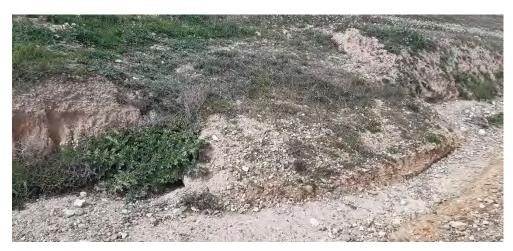
Fig. 2 Tubo de drenaje taponado por vegetación arbustiva y sedimentos en vial de acceso al aero VR1.07
