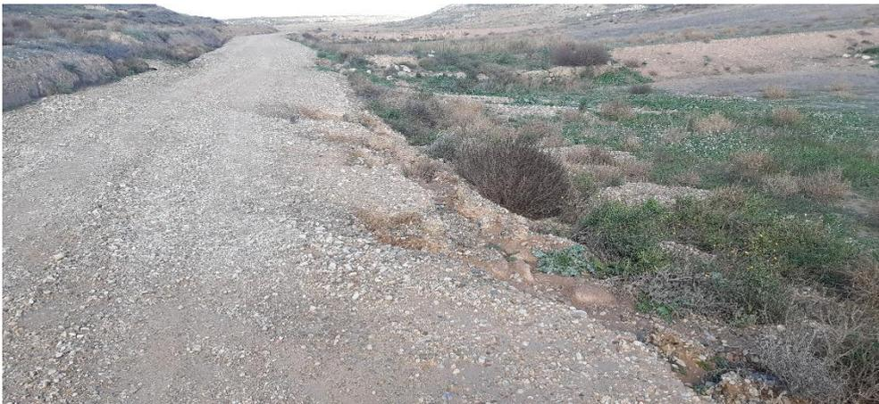
*Fig. 1 Erosión hídrica en materiales detríticos del vial de acceso al aero VR1.07. Peligro para circular*
