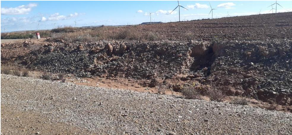
Fig. 3 Erosión hídrica en materiales lutíticos del talud de desmonte del vial de acceso al aero VR1.01.
