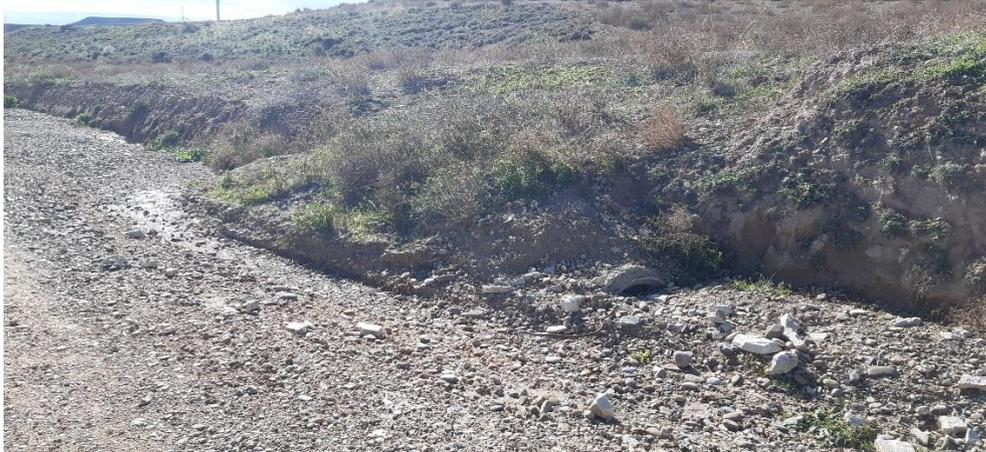
Fig. 2 Tubo de drenaje taponado por vegetación arbustiva y sedimentos en vial de acceso al aero VR1.07
