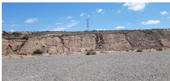
Fig. 5 Erosión del talud de desmonte de plataforma VGI.10.
