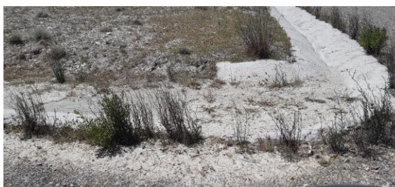
Fig. 2 Cuneta llena de sedimentos en la plataforma VGI.08
