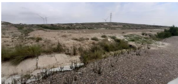
Fig. 1 Encharcamiento en margen de plataforma VGI.07
