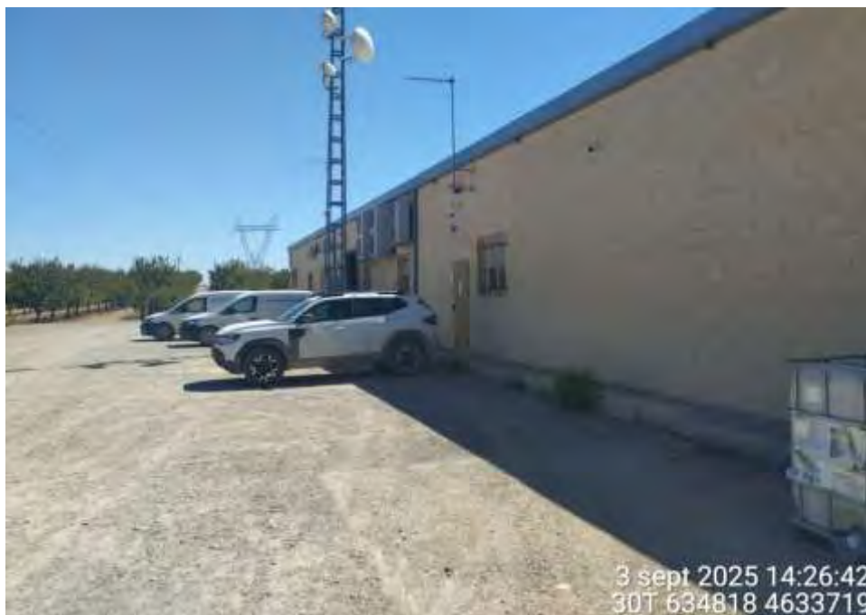
Figura 36: Subestación eléctrica Valcardera. SET asociada a PE “Tinajeros” en la que se realiza la gestión de residuos del PE.
