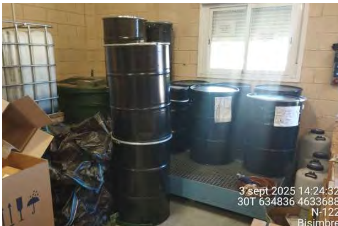
Figura 35: Interior del almacén de residuos de la SET, con los diferentes residuos peligrosos clasificados, aislados de la intemperie y sobre una tarima aislante para evitar posibles filtraciones al suelo.
