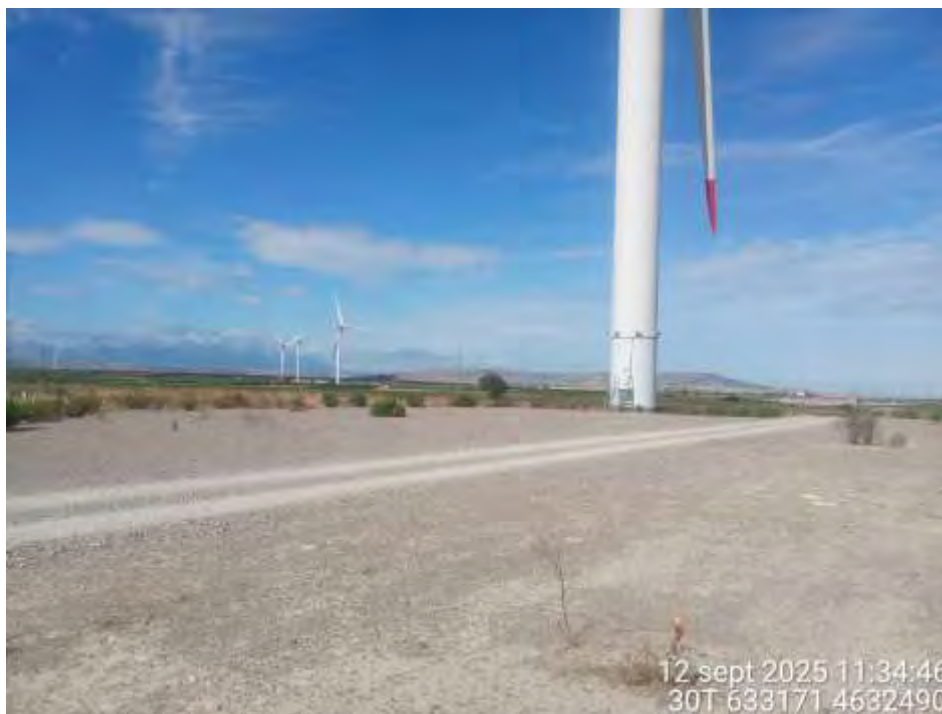
Figura 33: Vial de acceso y plataforma de TIN-03 en correcto estado de conservación.
