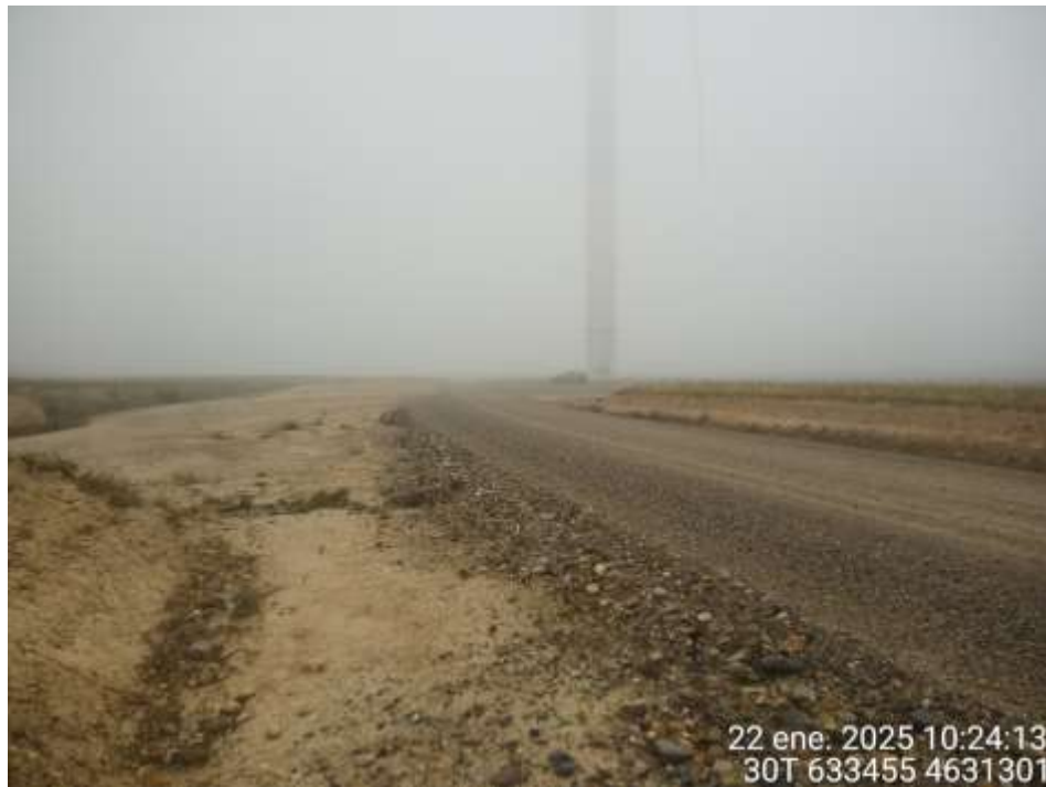
Figura 5: Vial de acceso TIN-07 correcto estado de conservación.
