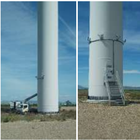
Figura 12: Fotografías de la instalación del Sistema “3D Observer” ubicado en la torre del aerogenerador TIN-2 (izquierda) y TIN-5 (derecha) durante este último cuatrimestre.
