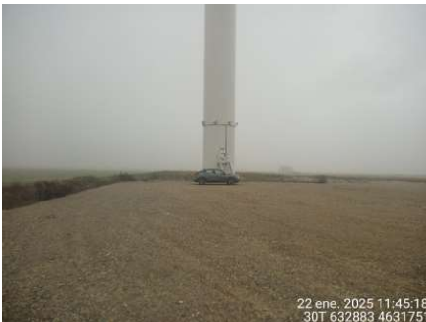
Figura 4: Vial de acceso TIN-05 correcto estado de conservación.
