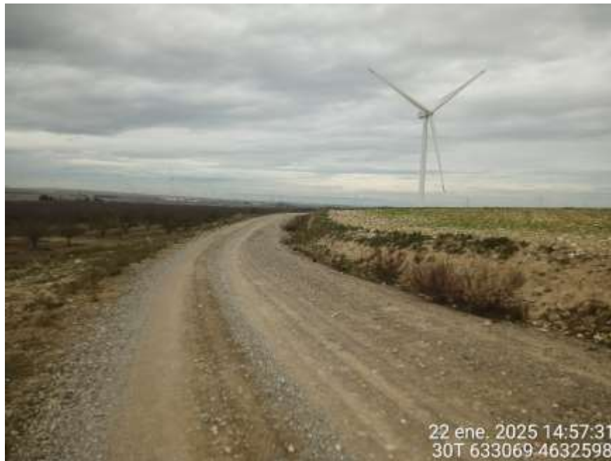
Figura 3: Vial de acceso a TIN-02 está en buen estado, sin alteraciones por paso de vehículos o por adversidades meteorológicas.
