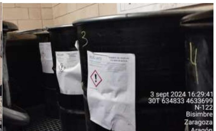
**Figura 34:** Interior del almacén de residuos de la SET, con los diferentes residuos peligrosos clasificados, aislados de la intemperie y sobre una tarima aislante para evitar posibles filtraciones al suelo.
