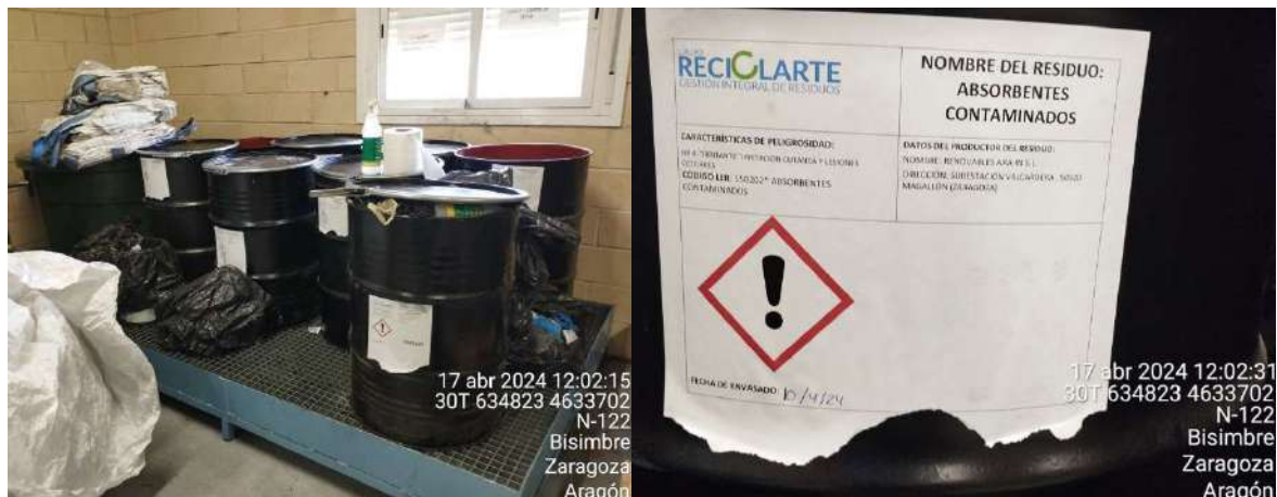
Figura 35: Interior del almacén de residuos de la SET, con los diferentes residuos peligrosos clasificados, aislados de la intemperie y sobre una tarima aislante para evitar posibles filtraciones al suelo.
