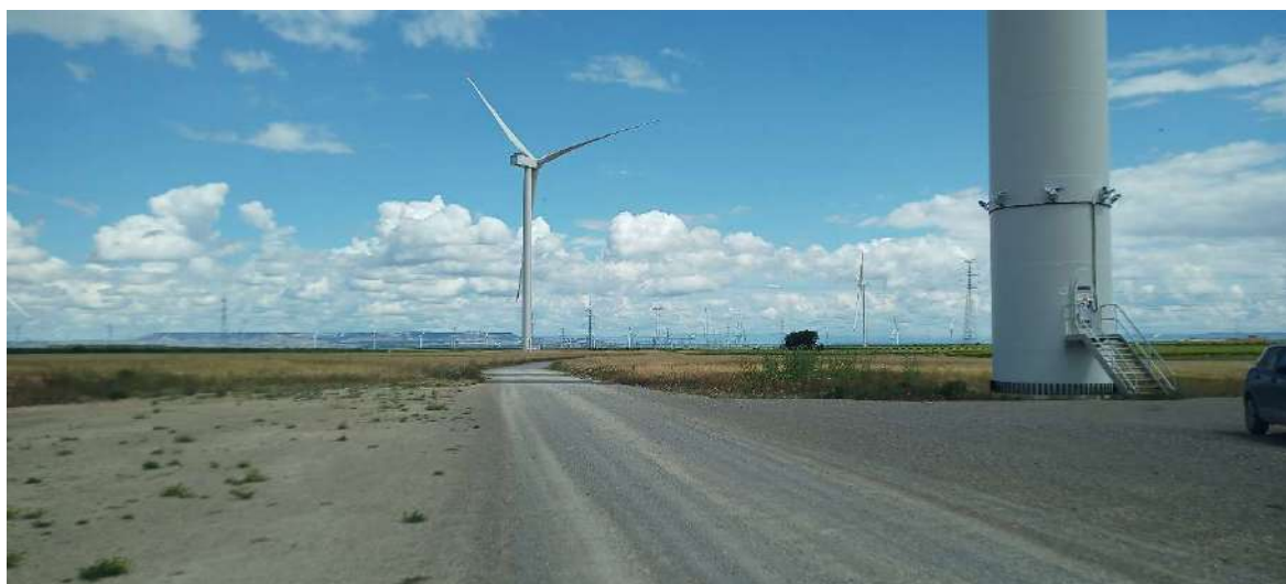
Figura 31: Vial de acceso a TIN-06 visto desde TIN-07, está en buen estado, sin alteraciones por paso de vehículos o por adversidades meteorológicas.
