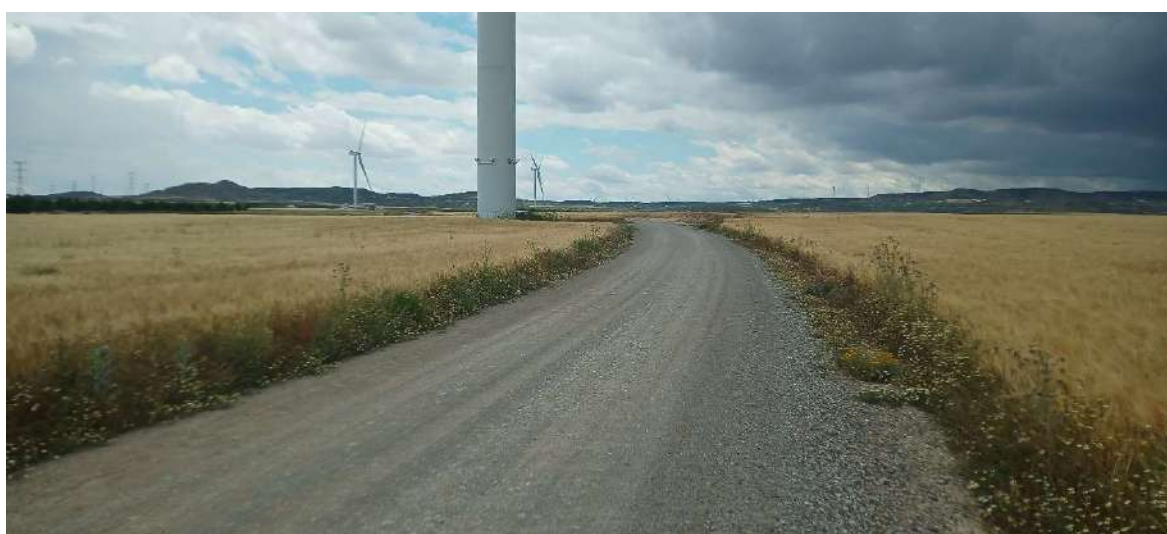
Figura 32: Vial que sale de TIN-06 hacia TIN-07 en correcto estado de conservación, salvo por algunos baches menores en su área central surgidos del paso de tráfico rodado.
