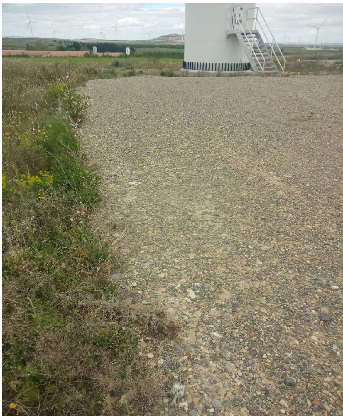
Figura 34: Plataforma de TIN-03 en correcto estado de conservación, vista desde la parte superior de un talud, que cuenta con un buen arraigo de vegetación natural que estabiliza los taludes.
