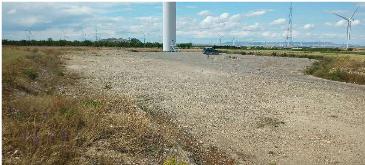
Figura 33: Plataforma de TIN-04 en correcto estado de conservación, vista desde la parte superior de un talud, que cuenta con un buen arraigo de vegetación natural que estabiliza los taludes.
