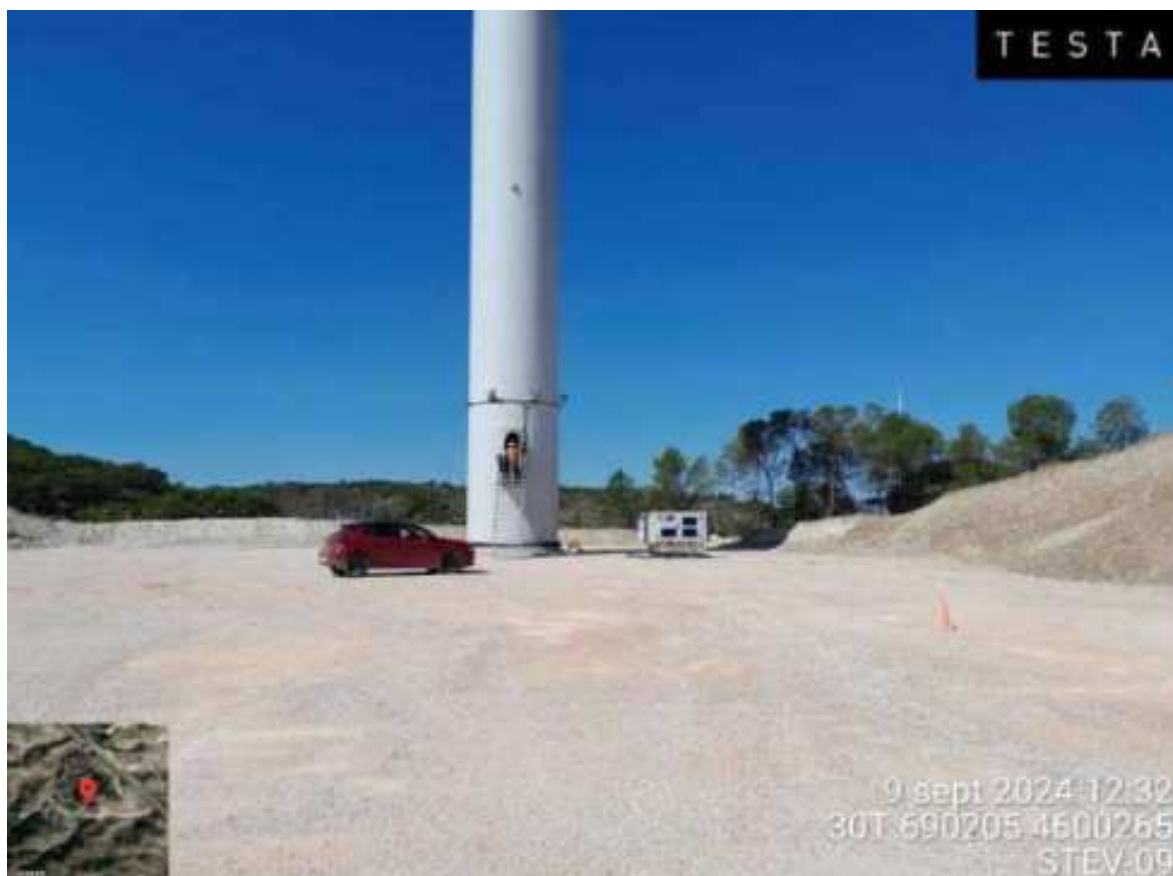
Imagen 2. Trabajos internos en STEV-09
