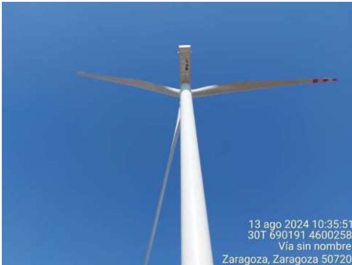
Imagen 1. Aerogenerador 09 de STEV montado.
