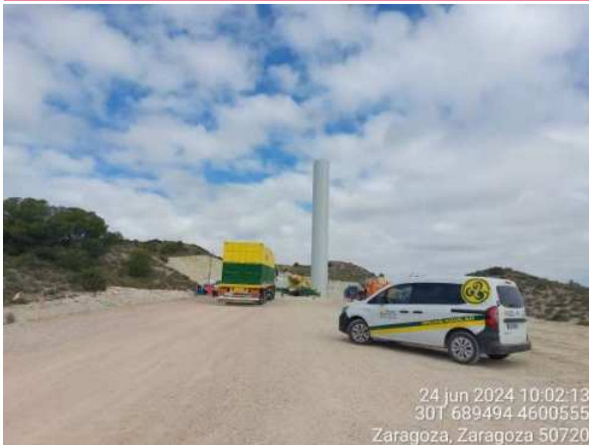
Imagen 2. Trabajos de montaje en STV-01.
