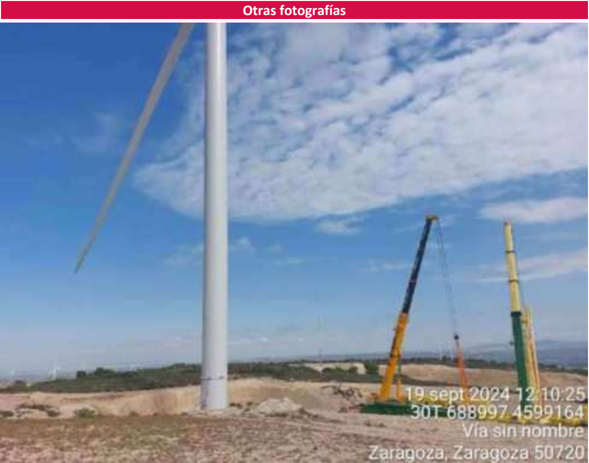
Imagen 1. STV-05 montado y equipos desmontando maquinaria.
