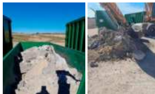
Cierre NC, retirada y eliminación pozos lavado
