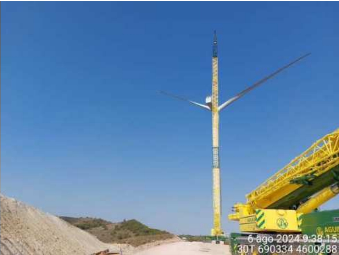
Imagen 1. Posición STV-09 tras el montaje finalizado.
