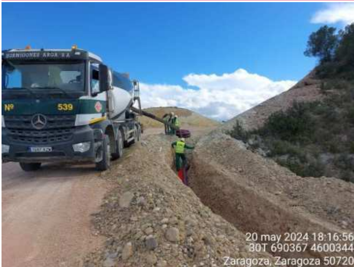
Imagen 1. Trabajos de hormigonado de zanja cerca de STV-09.
