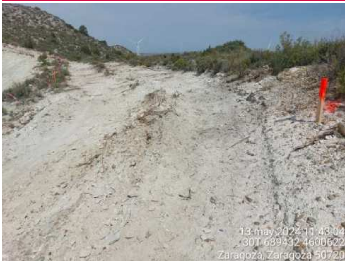
Imagen 2. Estaquillado en la zona de la zanja RMT donde se acopiarán bobinas.
