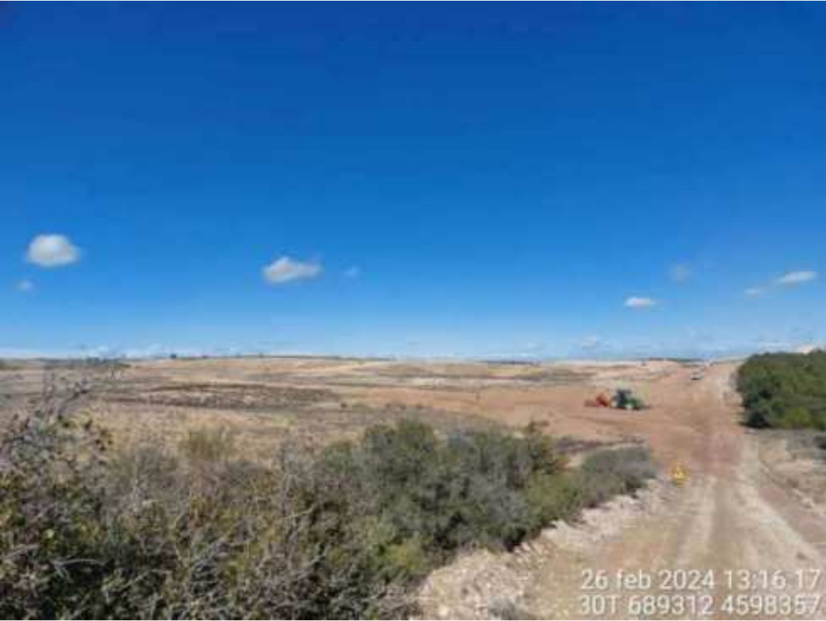
Imagen 1. Movimiento de tierras en el cruce de STEV-05 y STEV-07.
