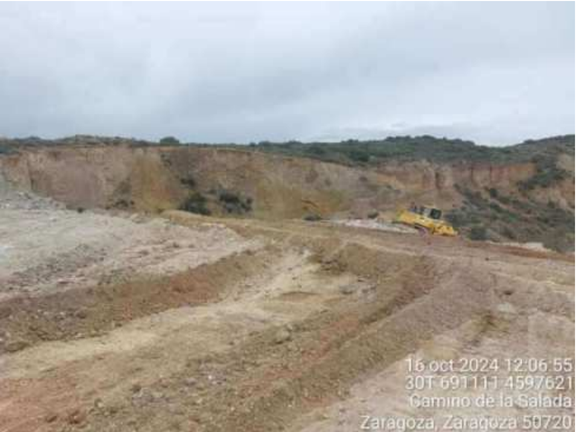
Imagen 1. Maquinaria comenzando los trabajos de restauración en la antigua gravera.
