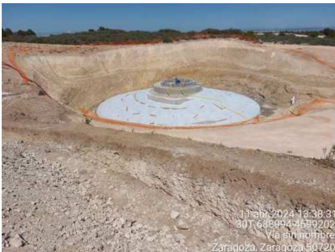
Imagen 2. STV-05 tras hormigonarse.
