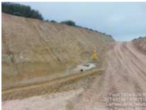
Talud pendiente de suavizar para hidrosiembra
