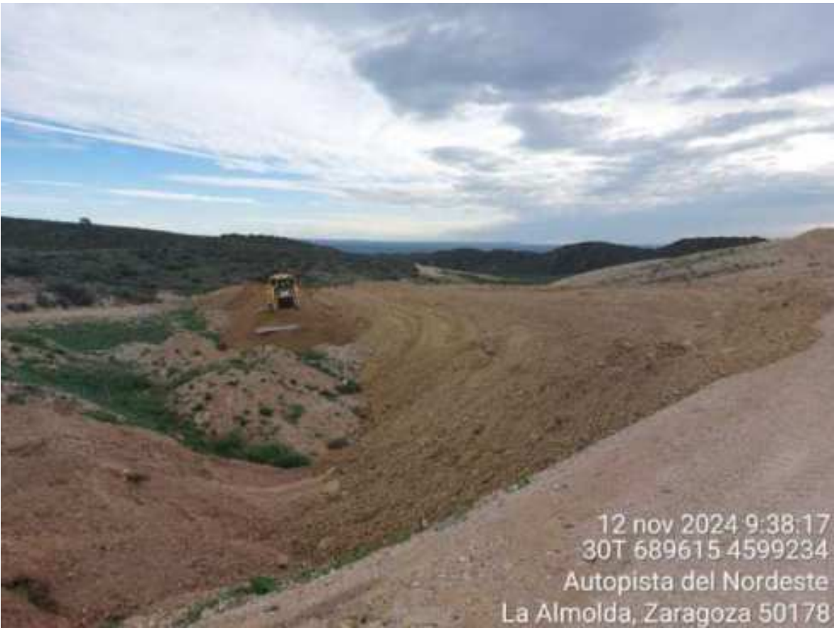
Imagen 1. Maquinaria retirando volvedero de STV-06.
