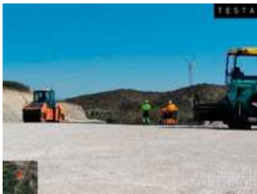
Trabajos de restauración en acceso principal
