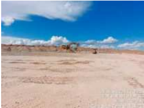
Movimiento de tierras en campa
