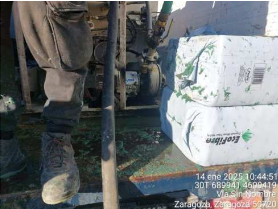
Imagen 1. Comienzo de los trabajos de hidrosiembra.
