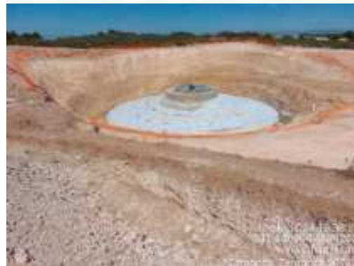
Hormigonado posición STV-05
