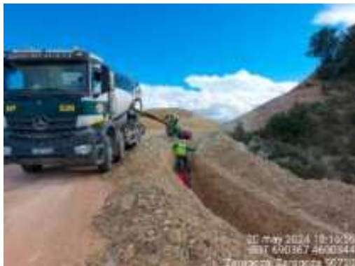
Hormigonado zanja
