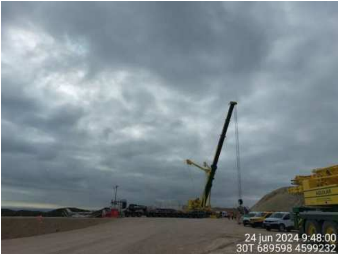
Imagen 1. Trabajos de premontaje en STV-06.
