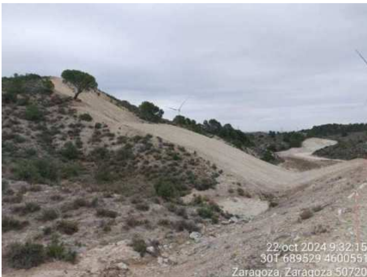
Imagen 2. Restauración de la zona de giro en STV-01 a falta de aportar la tierra vegetal.
