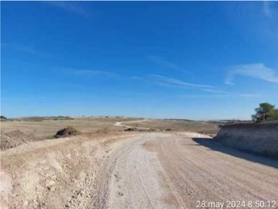
Imagen 1. Trabajos de ensanche y acondicionamiento del vial principal.
