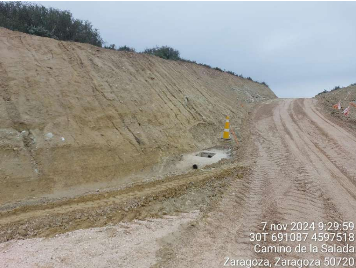
Imagen 1. Talud que se debe suavizar pendientes para hidrosebrar.
