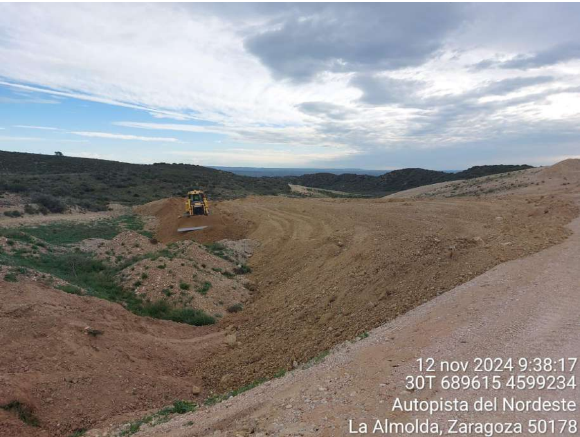
Imagen 1. Maquinaria retirando volvedero de STV-06.
