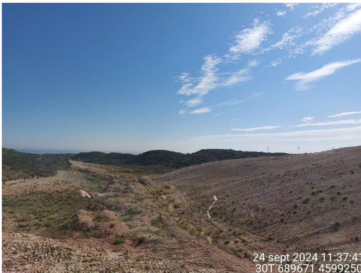
Imagen 1. Cordón de tierra vegetal que se utilizará en la restauración morfológica.
