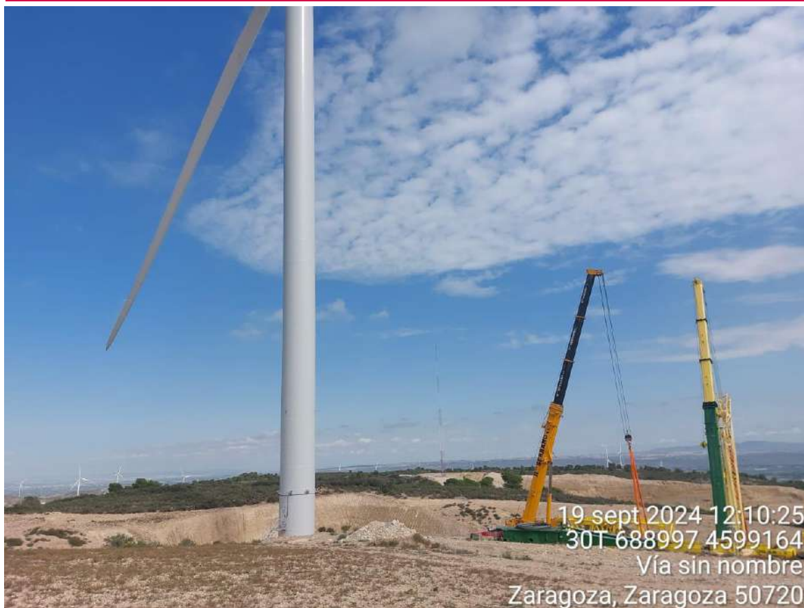
Imagen 1. STV-05 montado y equipos desmontando maquinaria.
