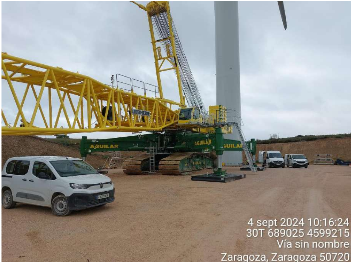
Imagen 1. Grúa en STV-05 tras realizar el montaje del aerogenerador.
