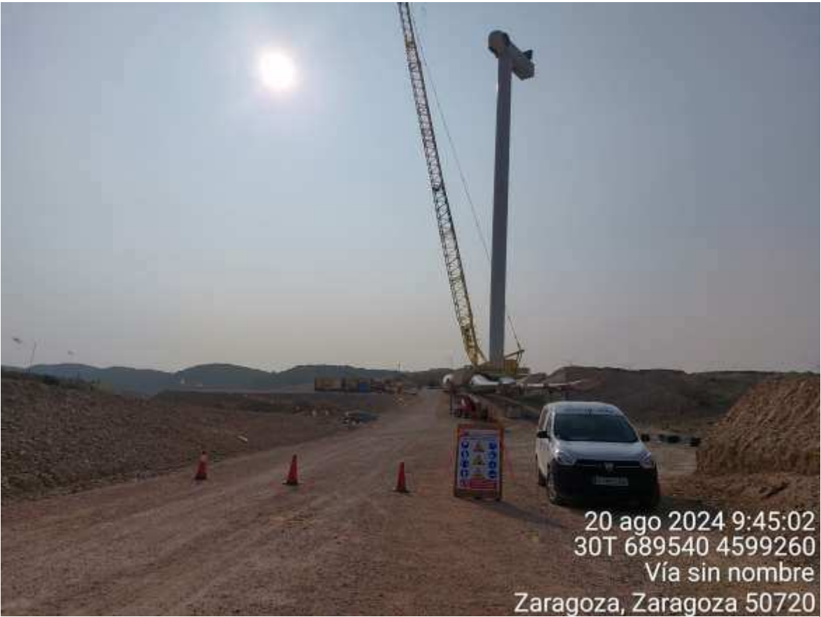
Imagen 1. STEV-06 con la grúa principal montada a la espera de poder subir las palas.
