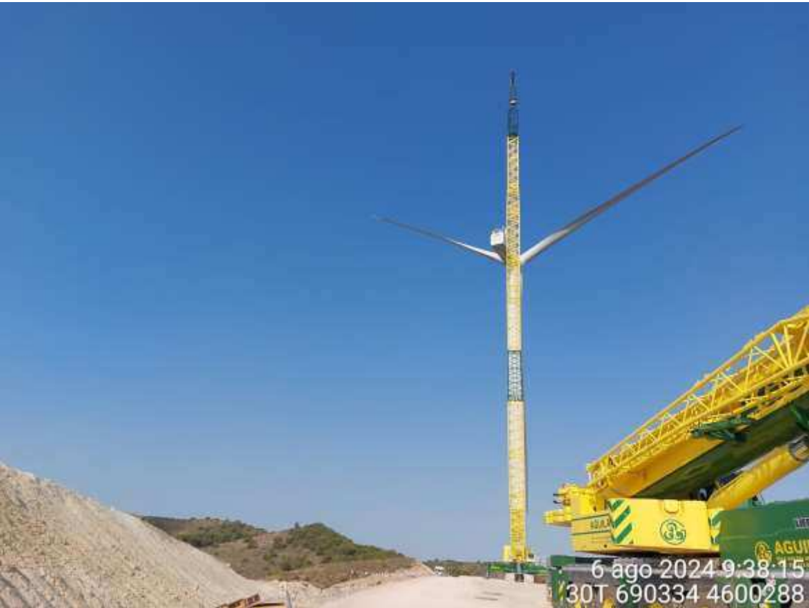
Imagen 1. Posición STV-09 tras el montaje finalizado.
