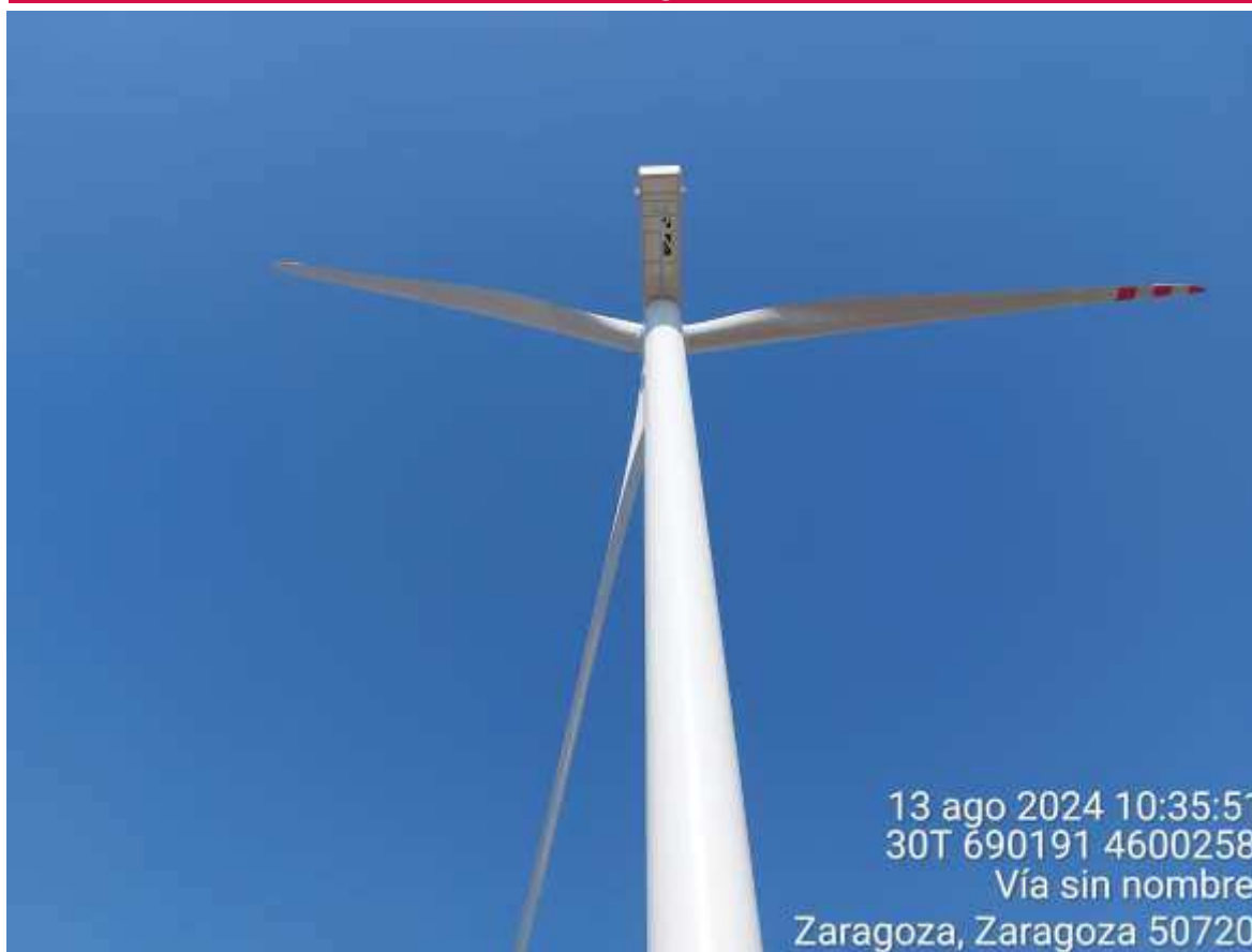
Imagen 1. Aerogenerador 09 de STEV montado.
