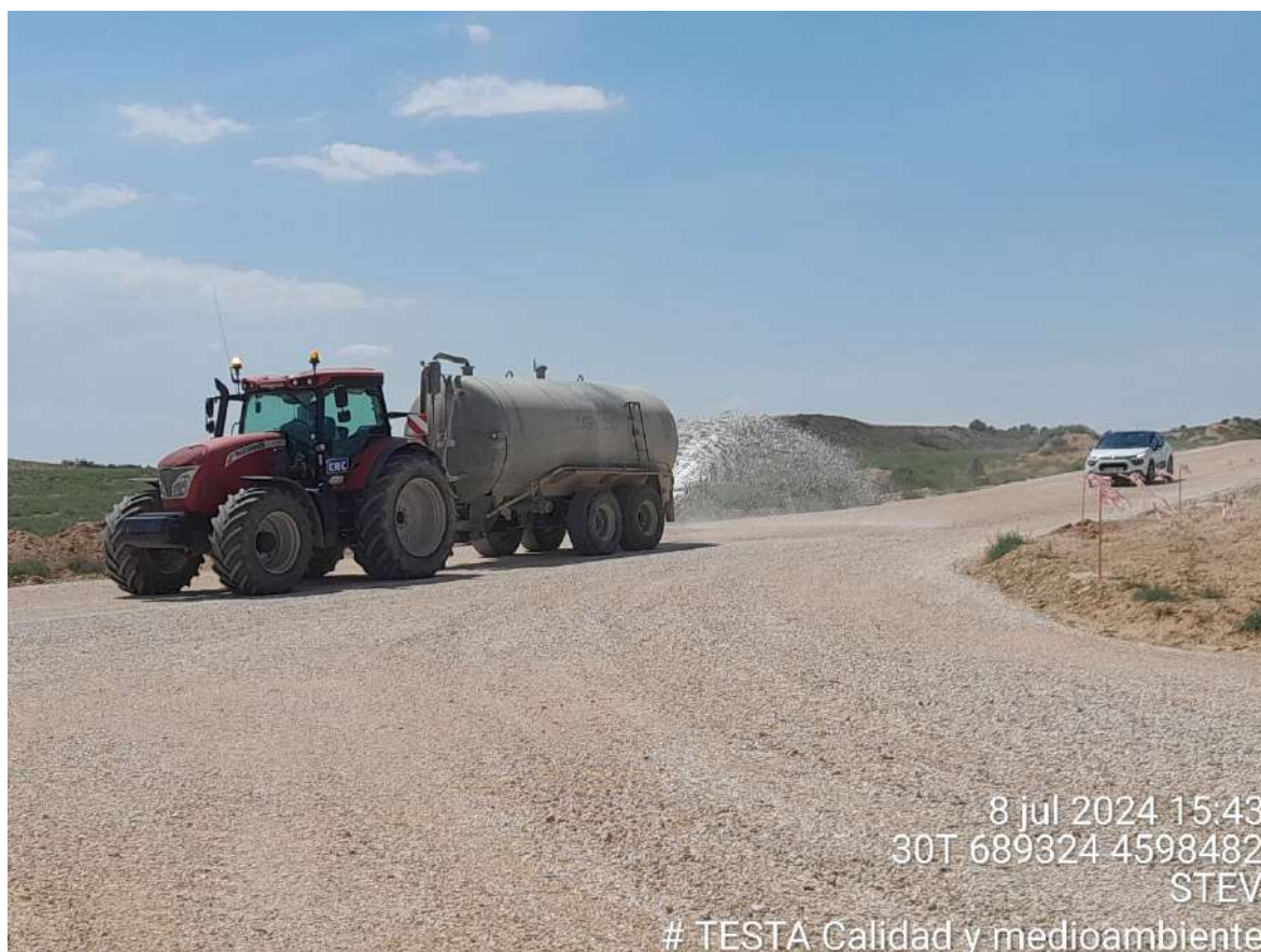
Imagen 2. Riego de viales, acceso a STEV-05 y STEV-07
