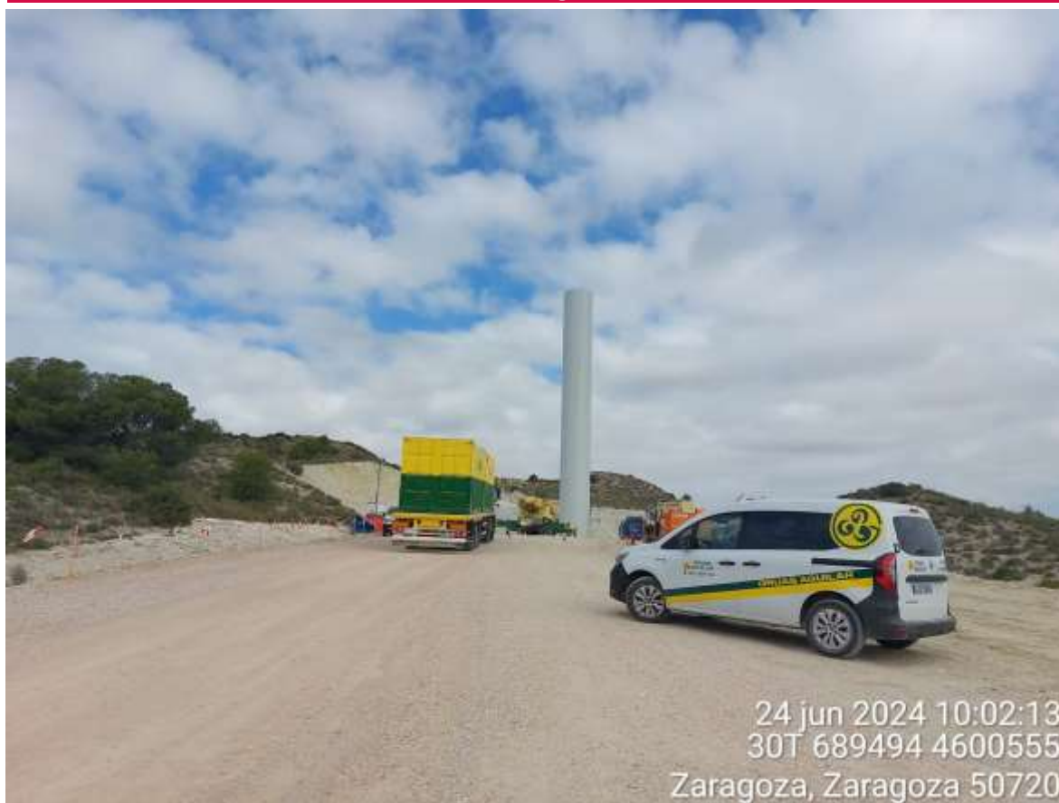
Imagen 2. Trabajos de montaje en STV-01.
