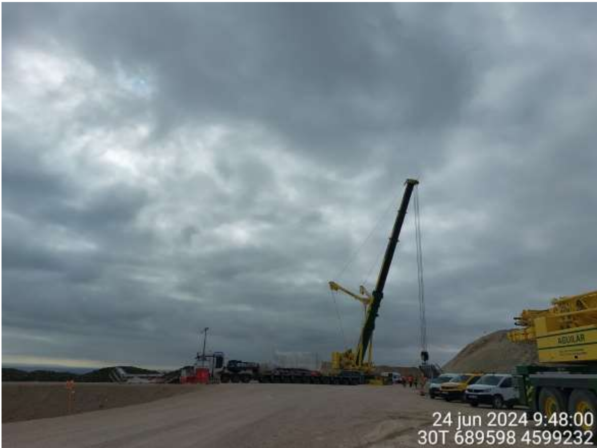
Imagen 1. Trabajos de premontaje en STV-06.
