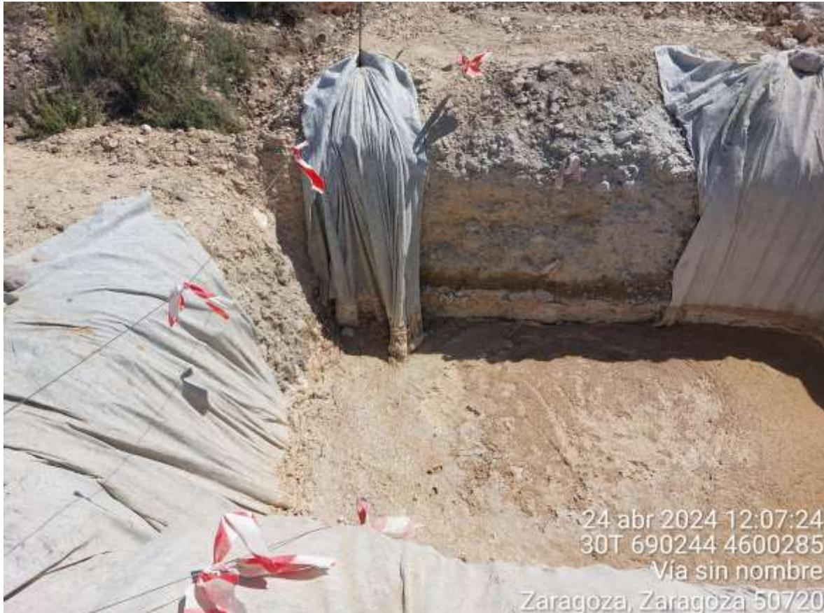
Imagen 1. NC leve. Pozo de lavado utilizado sin lograr la impermeabilización del suelo.
