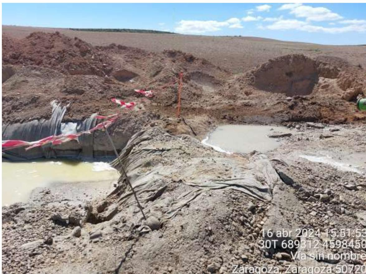
Imagen 2. No conformidad leve. Lavado incorrecto y contaminación del suelo con hormigón.
