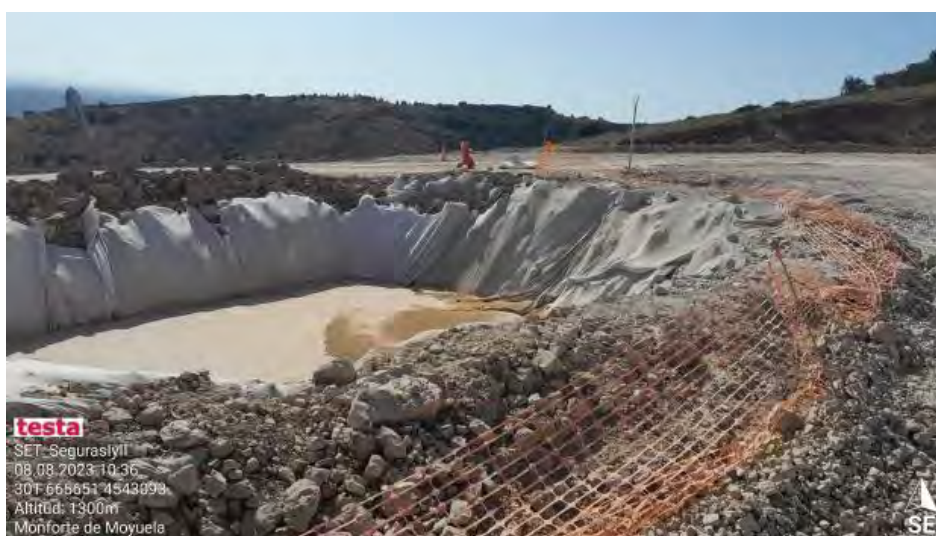
Reparación de balsa en SE2-3
