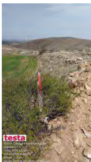
Estaquillado-Marcaje sin sujeción y sobre elementos naturales.
