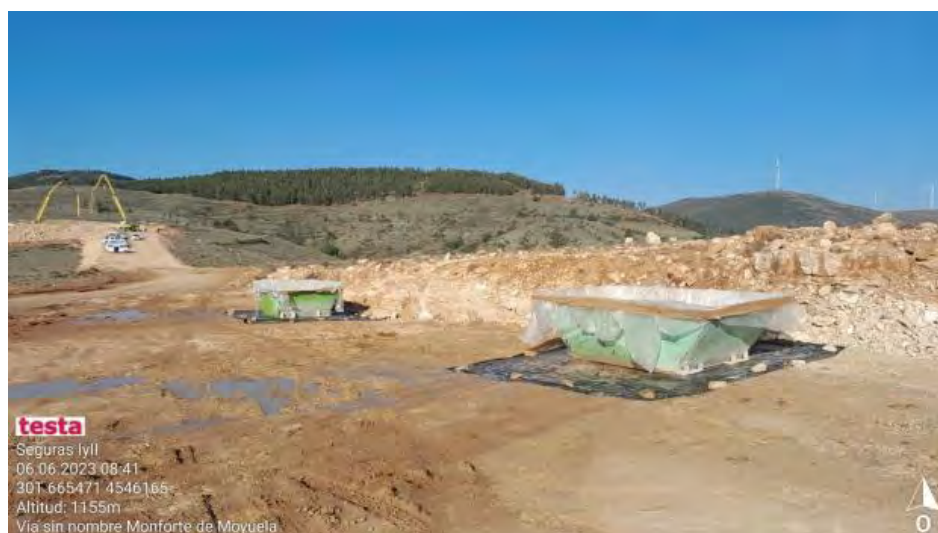
Contenedores para limpieza de hormigón.
