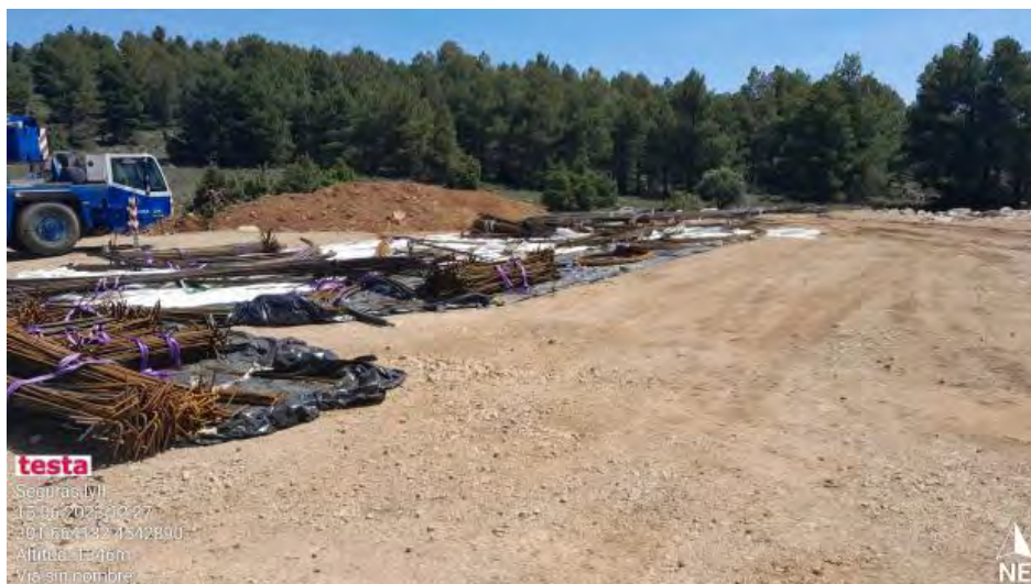
Ferralla con manta de protección de suelos.
