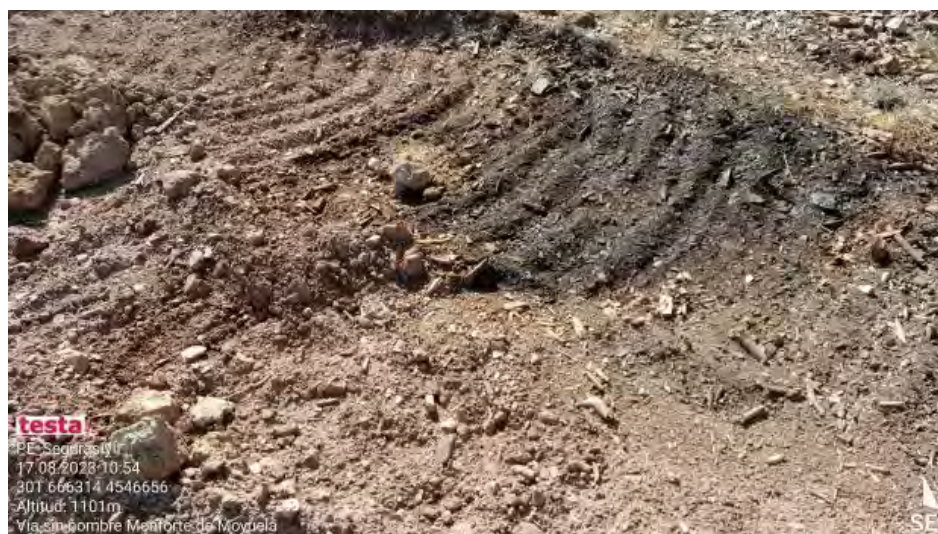
Mancha de líquido hidráulico localizada en lateral del vial principal en el acceso al parque .
