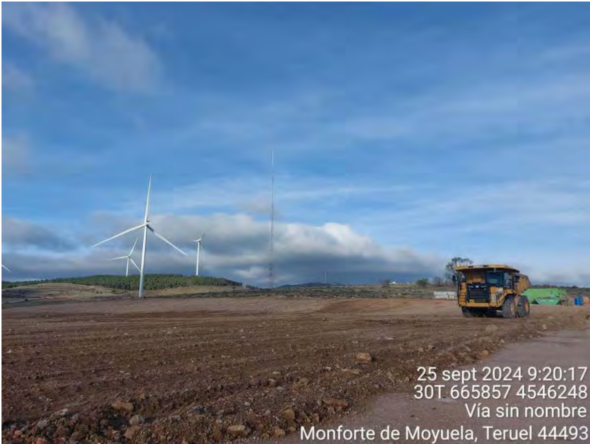
Imagen 1. Restauración de la campa Seguras junto con el extendido de la tierra vegetal.
