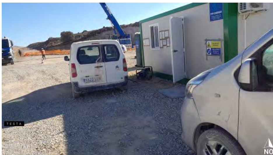
Generador sin protección de suelo en SE2-1
