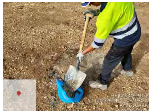
Subsanación no conformidad NC 20 derrames de maquinaria pesada
