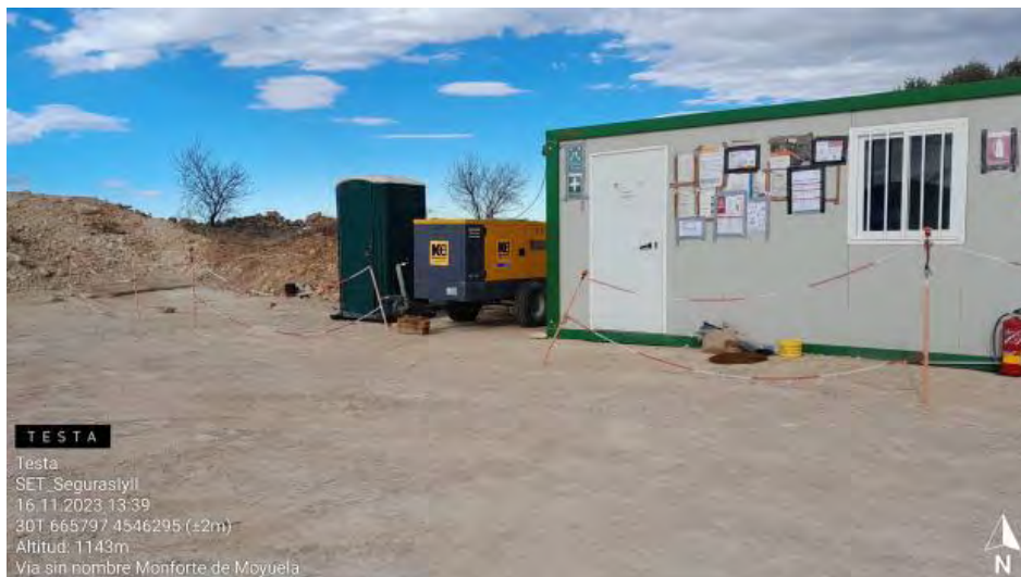
Generador sin protección de suelo .
