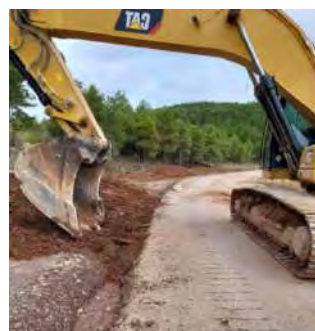
Subsanación no conformidad NC10 separación y mezcla incorrecta de tierra vegetal
