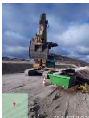
Subsanación no conformidad NC 12 vertido de hormigón por incidente de vehículo
