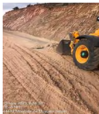
Evidencia de eliminación del hormigón NC 04 Contaminación suelo por residuo hormigón
