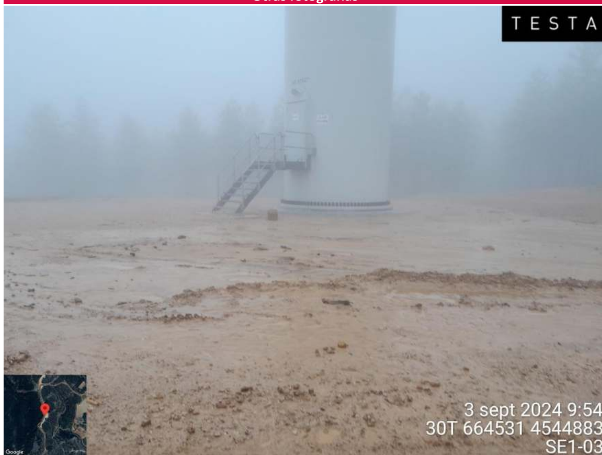
Imagen 1. Plataforma SE1-03 cubierta por material arrastrado, como consecuencia de las fuertes lluvias
