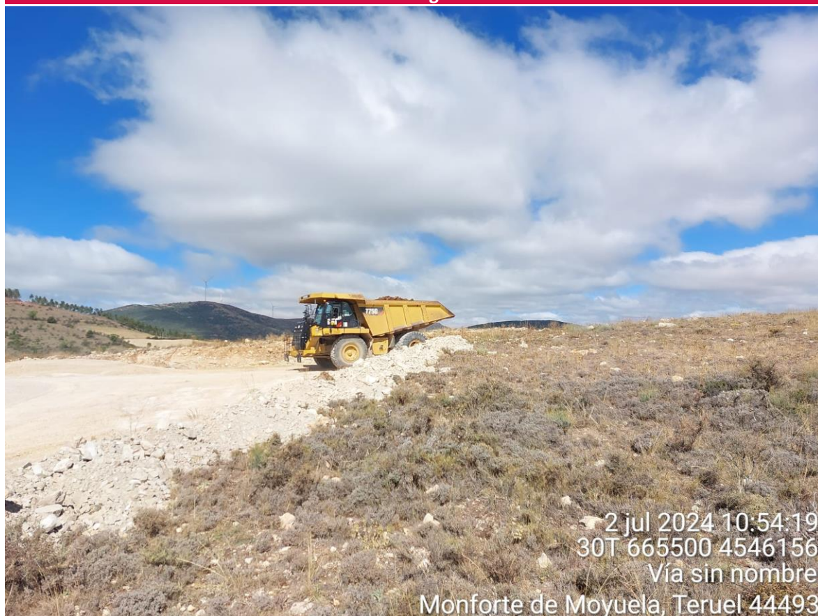
Imagen 1. Trabajos de restauración en la plataforma SE2-10
