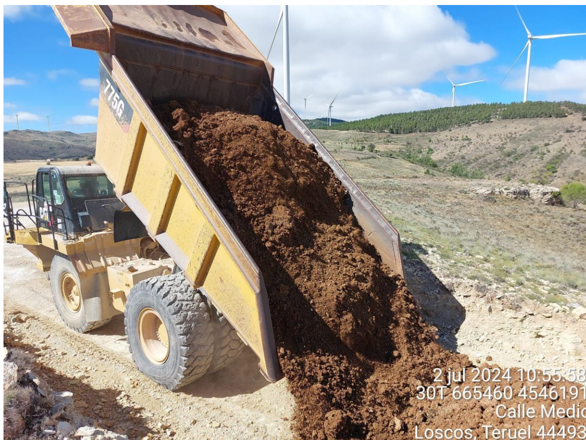
Imagen 2. Movimientos de tierra en la plataforma SE2-10
