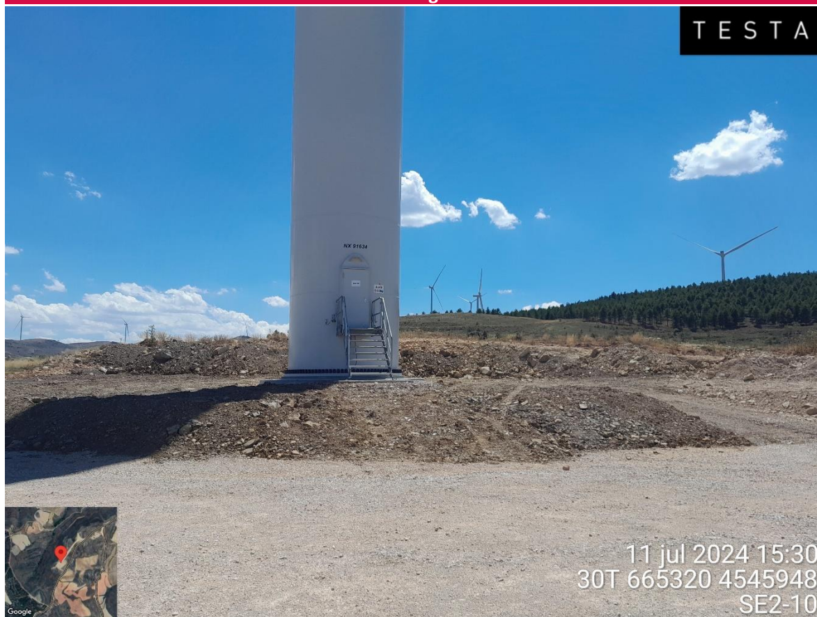
Imagen 1. Trabajos de restauración en la plataforma SE2-10
