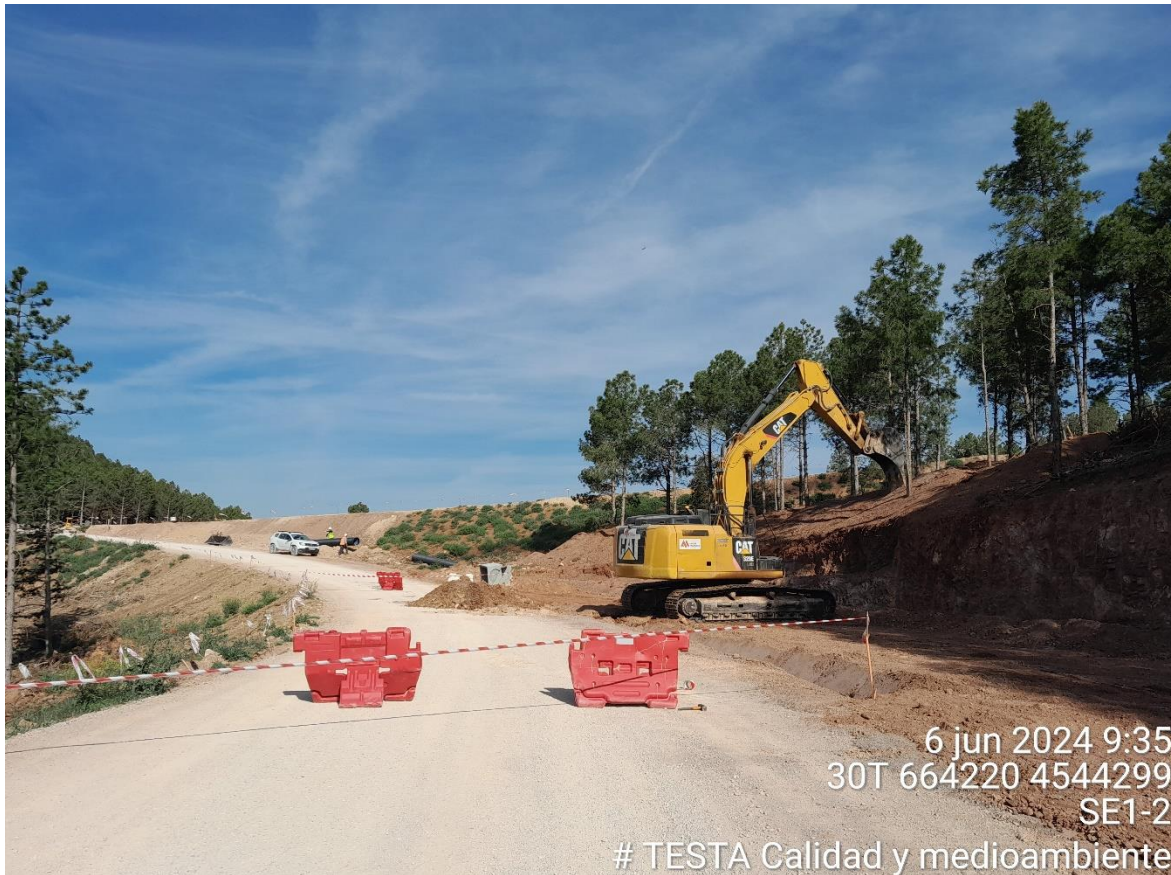
Imagen 1. Balizado vial acceso a SE1-2
