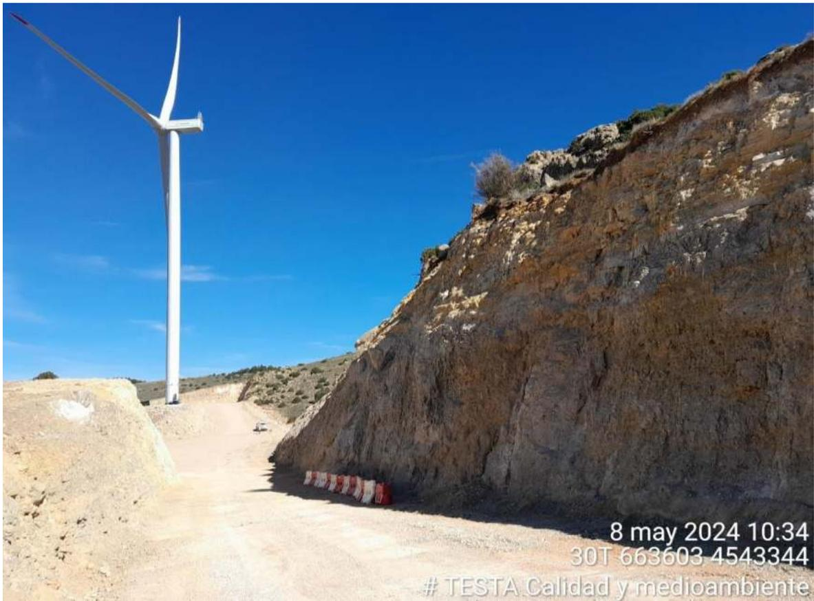
Imagen 1. Taludes de acceso a plataforma SE2-12
