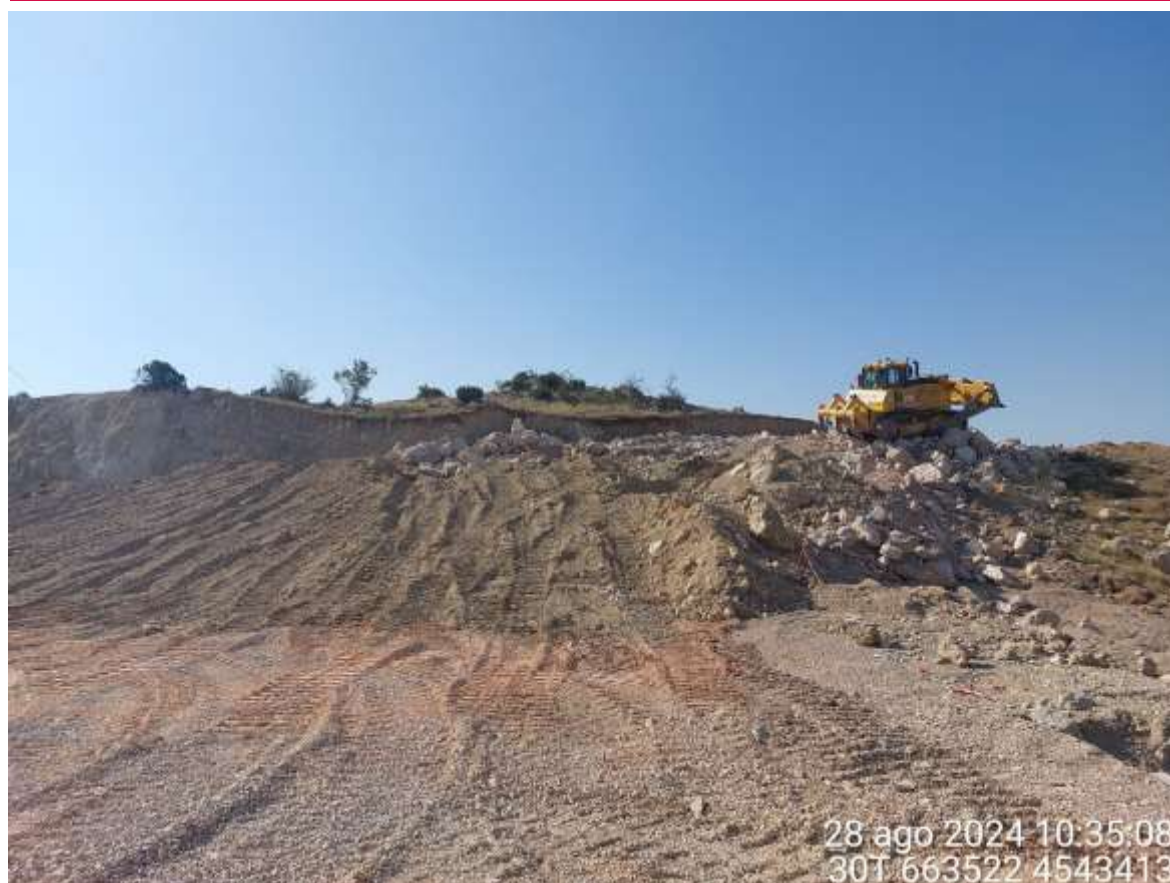
Imagen 1. Maquinaria pesada realizando trabajos de restauración en SE2-12.
