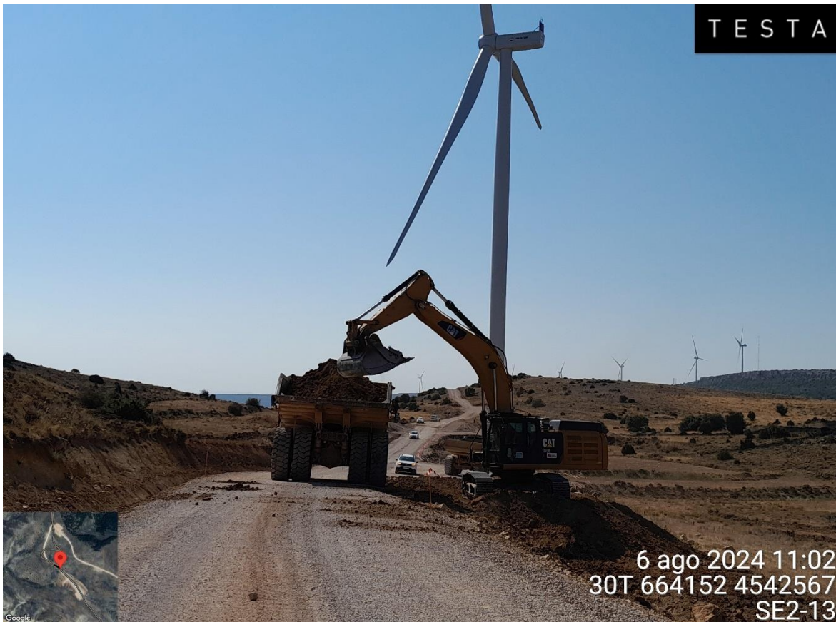
Imagen 2. Movimientos de tierra en la posición SE2-13
