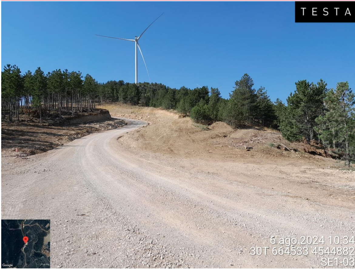
Imagen 1. Vista de los taludes de la posición SE1-03
