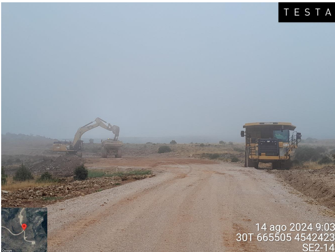
Imagen 2. Trabajos de restauración (movimientos de tierra) en la posición SE2-14
