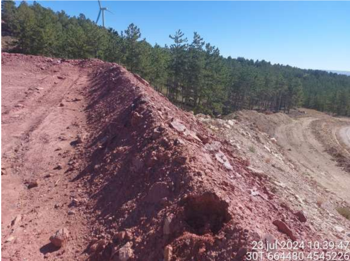
Imagen 1. Talud sobre el que se deben realizar trabajos de restauración morfológica.
