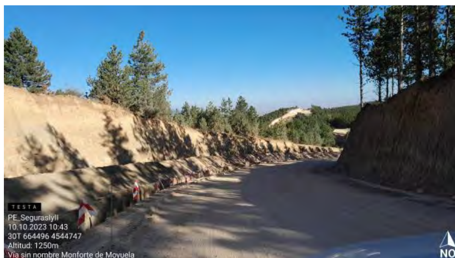
Zanja de evacuación en SE1
