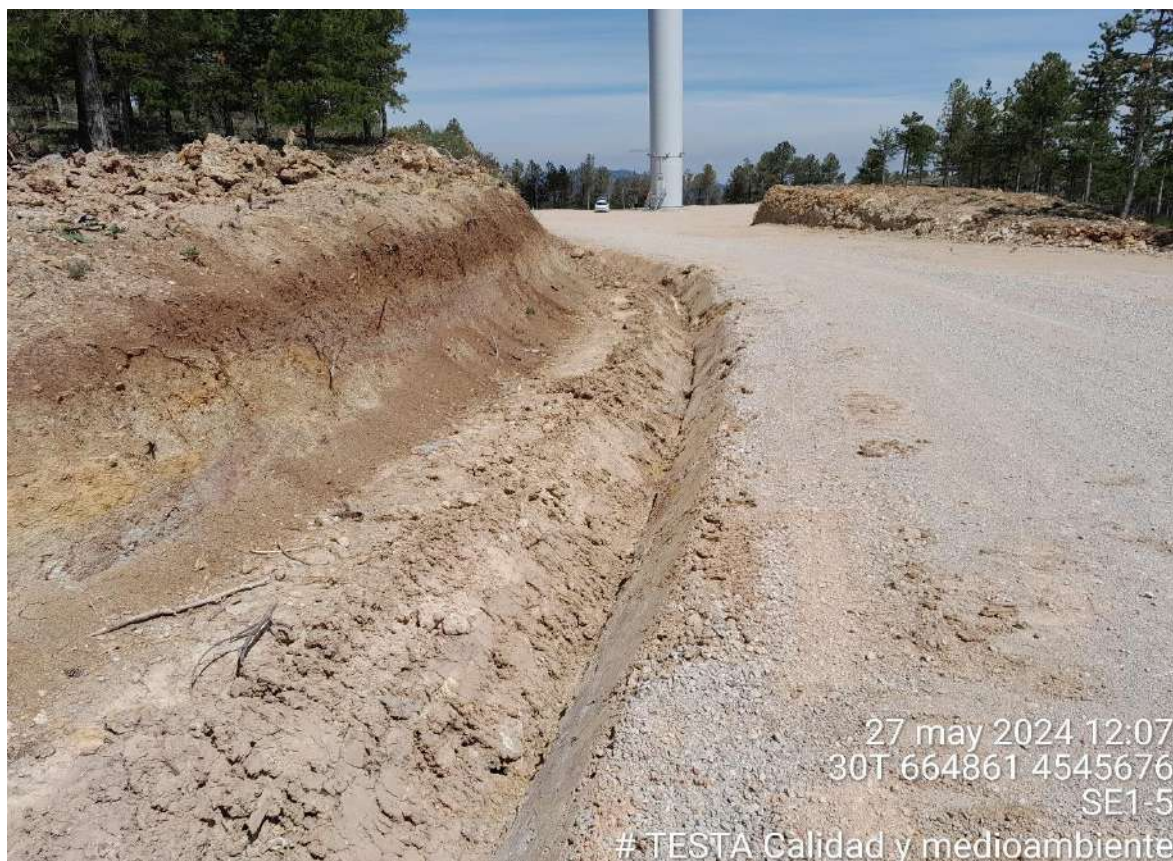
Imagen 2. Vial de acceso a SE1-5. Cuneta
