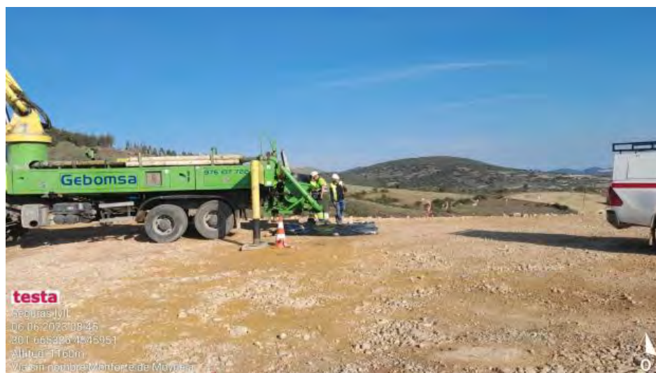
Aislamiento para derrames en bomba.
