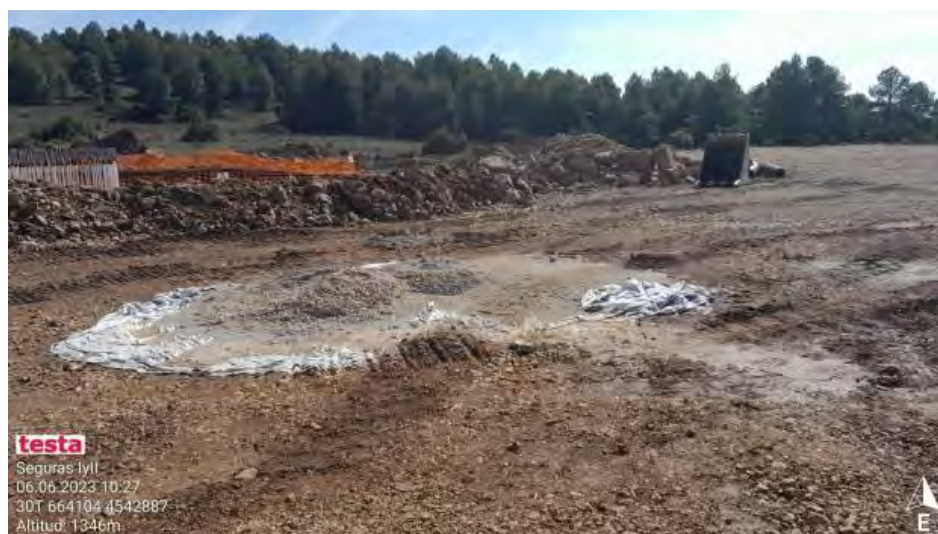
Aislamiento de hormigón con pequeño derrame
