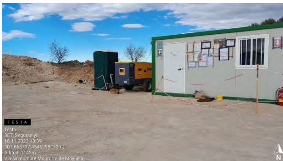
Generador sin protección de suelo .
