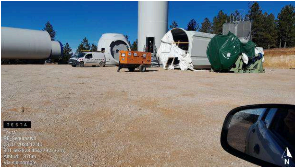
Generadores sin protección en SE1-1
