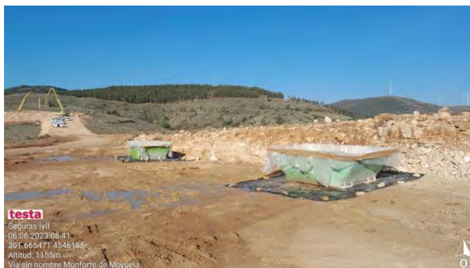
Contenedores para limpieza de hormigón.
