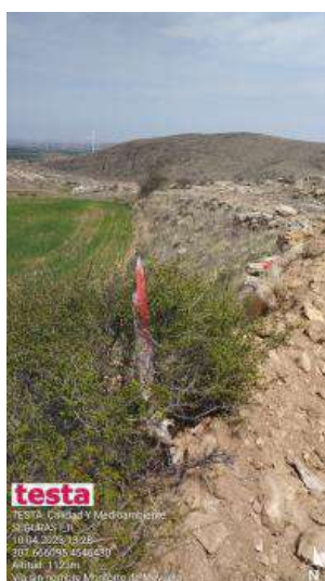
Estaquillado-Marcaje sin sujeción y sobre elementos naturales.
