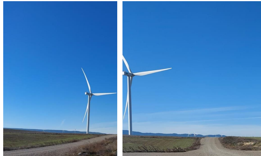
Fotografías 8 a 9: Estado de caminos y viales
