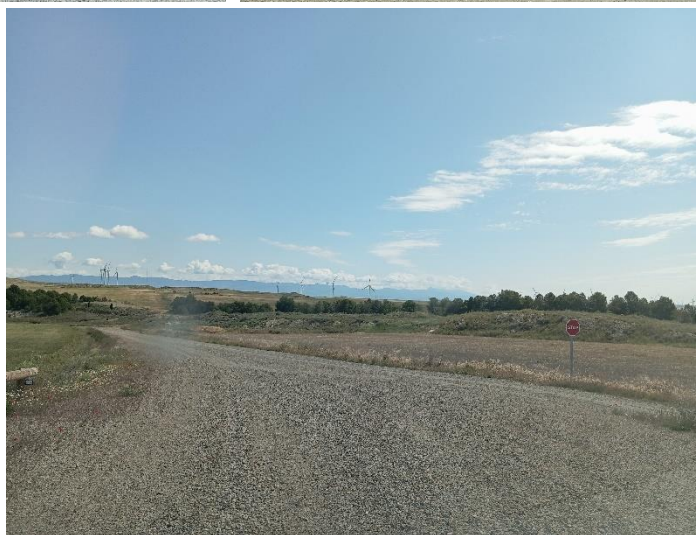
Fotografías 9 a 11: Estado de caminos y viales
