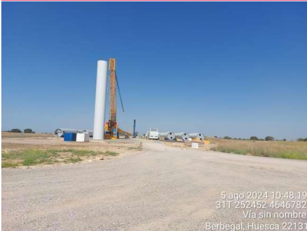
Imagen 1. Montaje de la posición SC4-02 paralizado debido a la alerta roja por incendios forestales.
