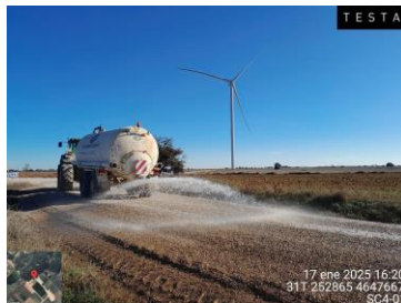
Riego de viales
