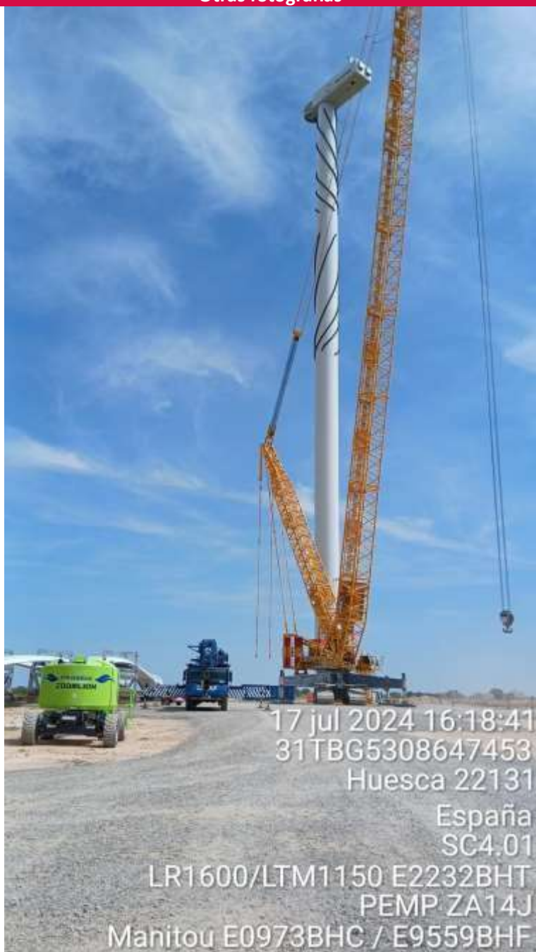
Imagen 1. SC4.01 Montaje principal de palas.
