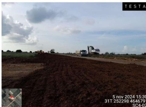
Maquinaria realizando movimientos de tierra, extendido de tierra vegetal.
