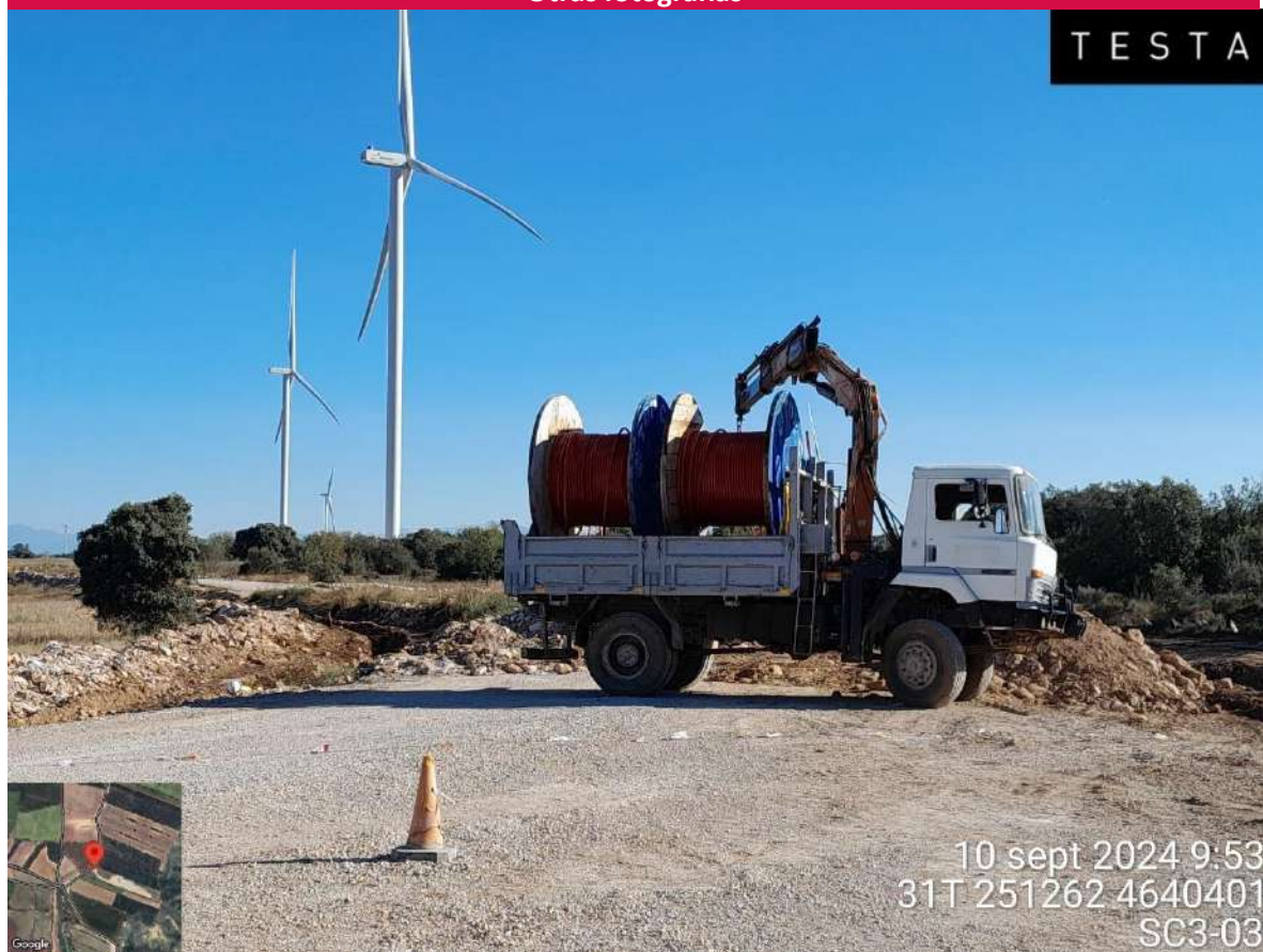
Imagen 1. Tirada de cable en SC3-03
