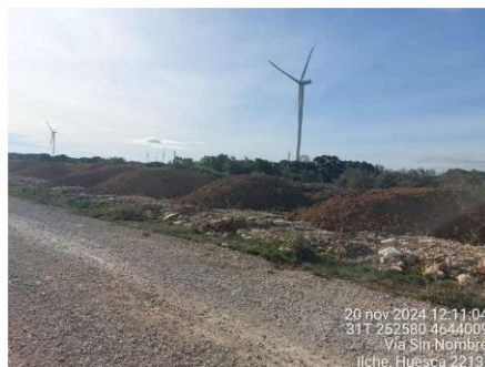
Acopios de tierra vegetal para ser extendidos
