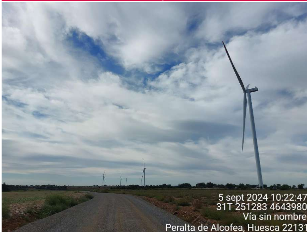
Imagen 1. Aerogeneradores SC4-04 (al frente) y SC4-03 (al fondo) montados.
