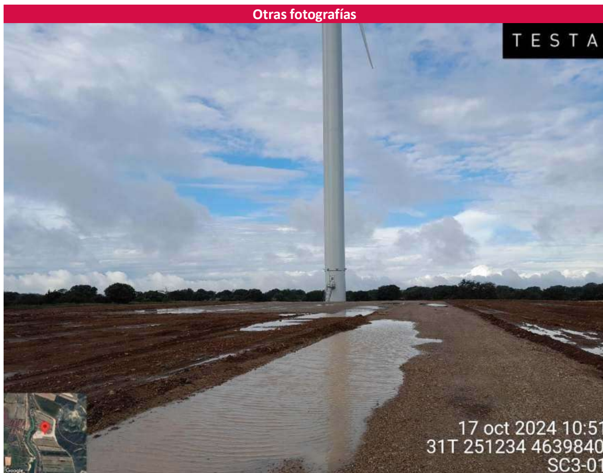
Imagen 1. Restauración de la posición SC3-01
