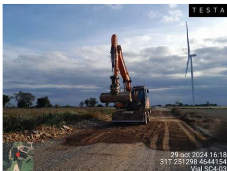
Trabajos de restauración en vial SC4-03
