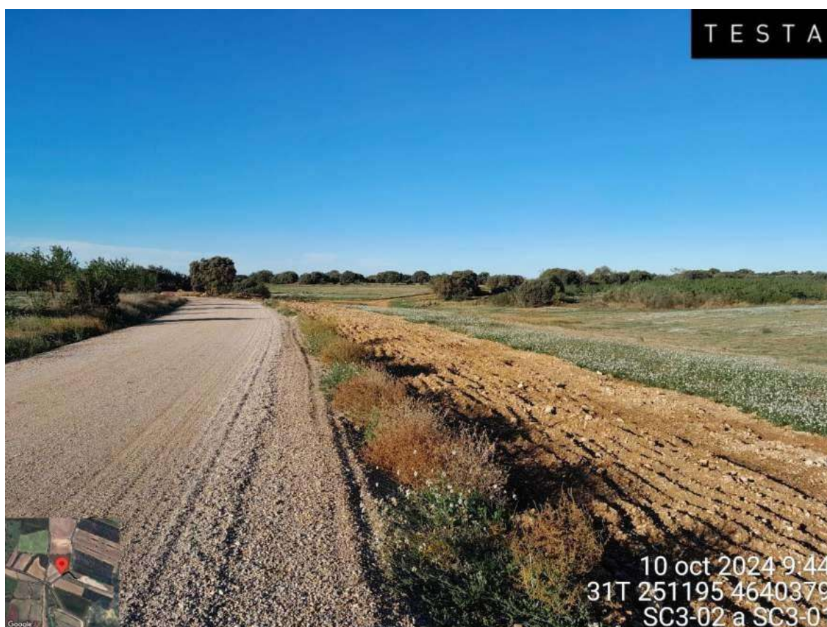
Imágenes 1 y 2. Posición SC3-01 y vial de acceso en restauración
