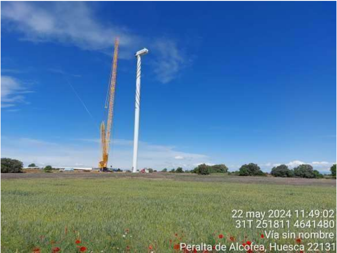
Imagen 1. Montaje del aerogenerador SC3-04.
