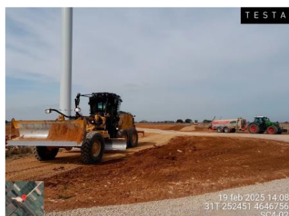
Restauración en SC4-02
