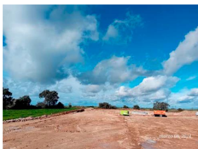
NC contaminación pozo lavado
