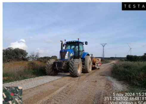
Trabajos restauración en vial de acceso
