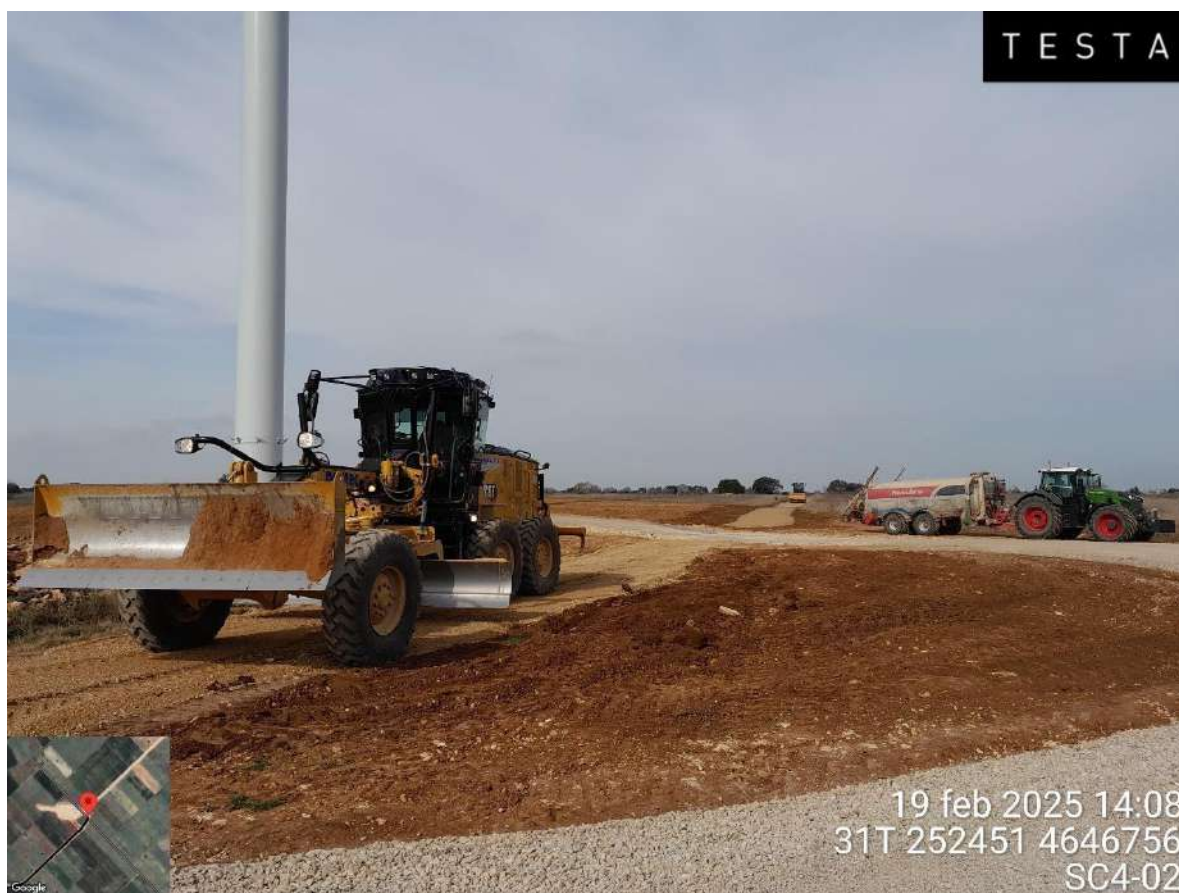
Imagen 1. Trabajos de restauración en SC4-02
