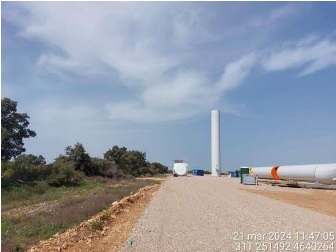
Ilustración 1. Montaje en SC3-03.
