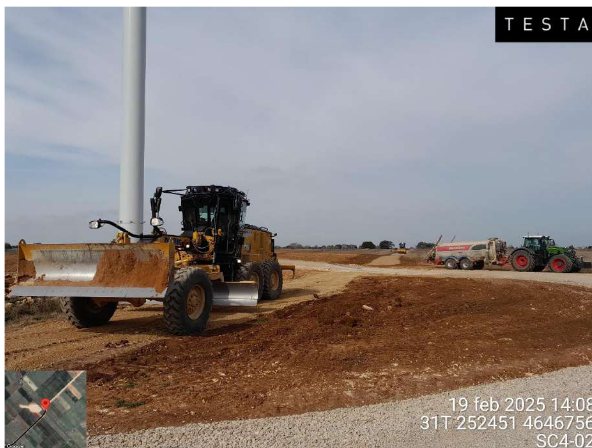
Imagen 1. Trabajos de restauración en SC4-02
