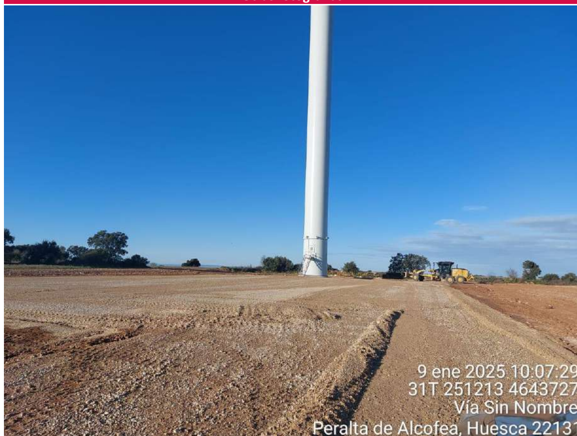
Imagen 1. Trabajos de acondicionamiento de viales y plataformas en SC4.
