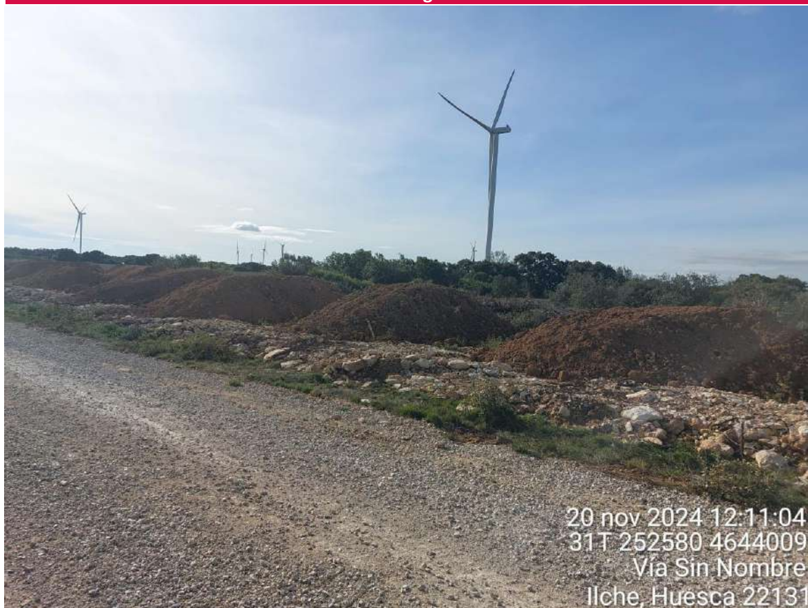
Imagen 1. Acopios de tierra vegetal listos para ser extendidos.
